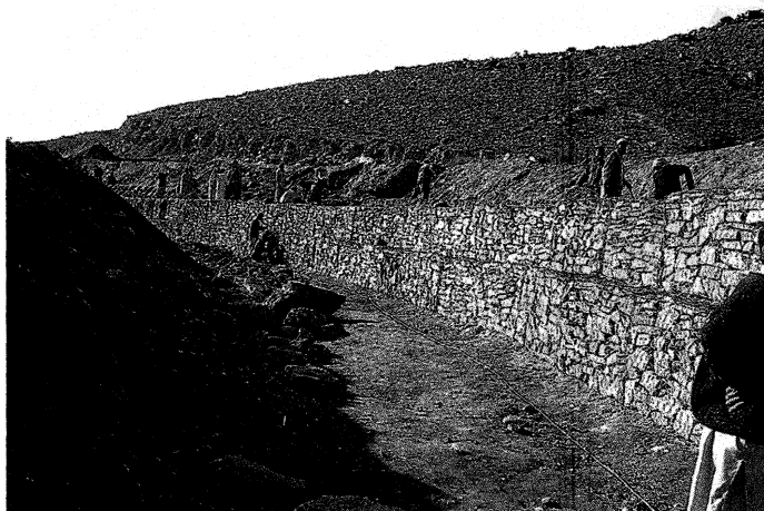
ジャカゴ 蛇籠で築かれた水路堤防
