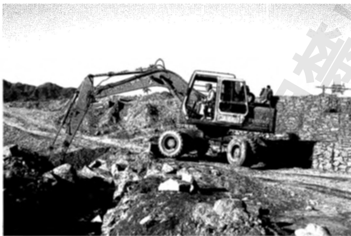
自ら重機を操って陣頭指揮をとる中村
