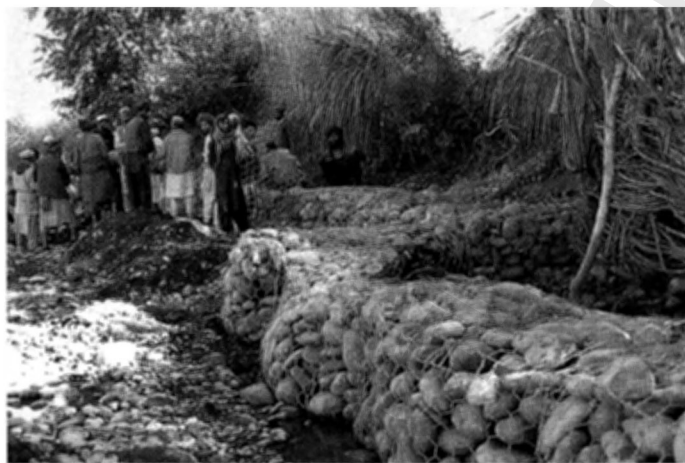
堤防として使用された地元の蛇籠 じやかご
