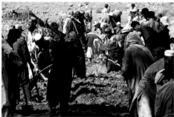
用水路の掘削現場。1日約600名が建設に従事する（2003年5月）
