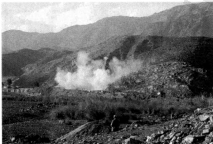
用水路の掘削では毎日ダイナマイトによる発破が行われる
