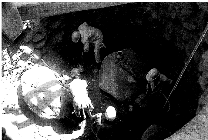
巨石を除去しながらの井戸掘削作業
