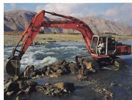
用水路の取水堰で油圧シャベルを運転して改修作業をする中村医師。2011年1月。
