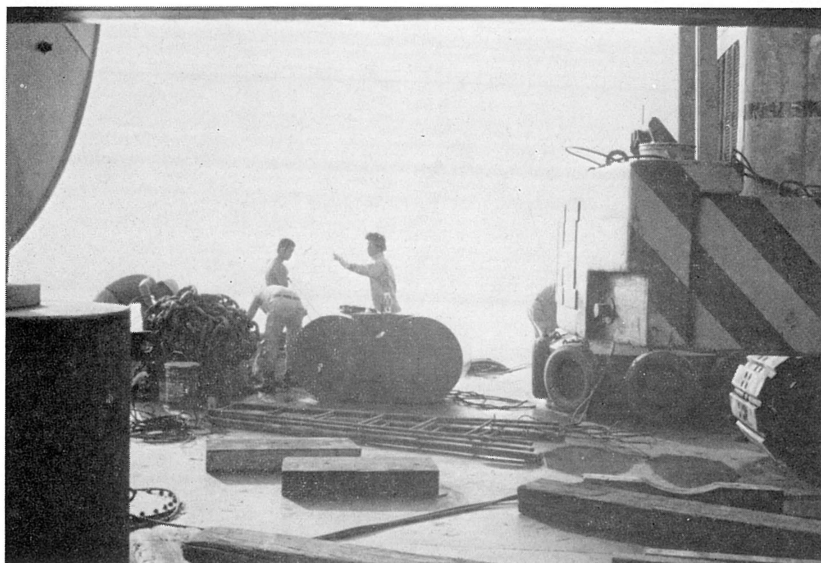
写真 5.5.3 パワーパイと中間パイ その1
