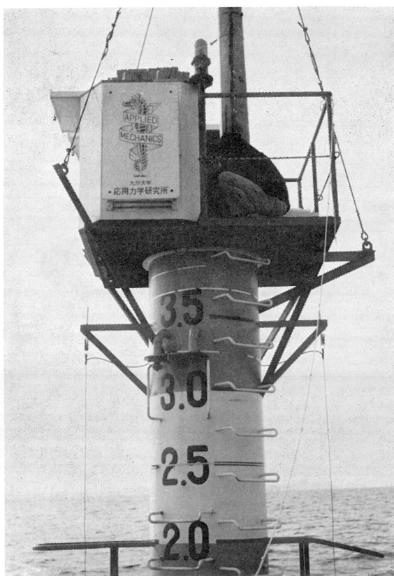
写真 5.5.9 計測器調整作業 その1
