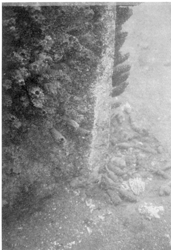
写真 5.6.6 シンカー隅部 ナイロンロープにより擦った跡がある
