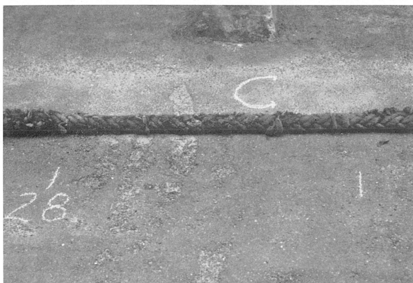
写真 5.6.4 ナイロンロープ損傷部 C
