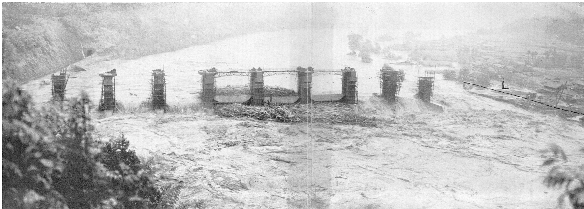
写真一 洪水時の夜明ダムの全景
