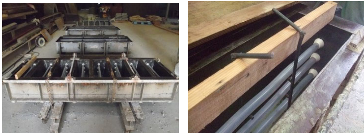
写真 6.4-3 型枠のセット状況
