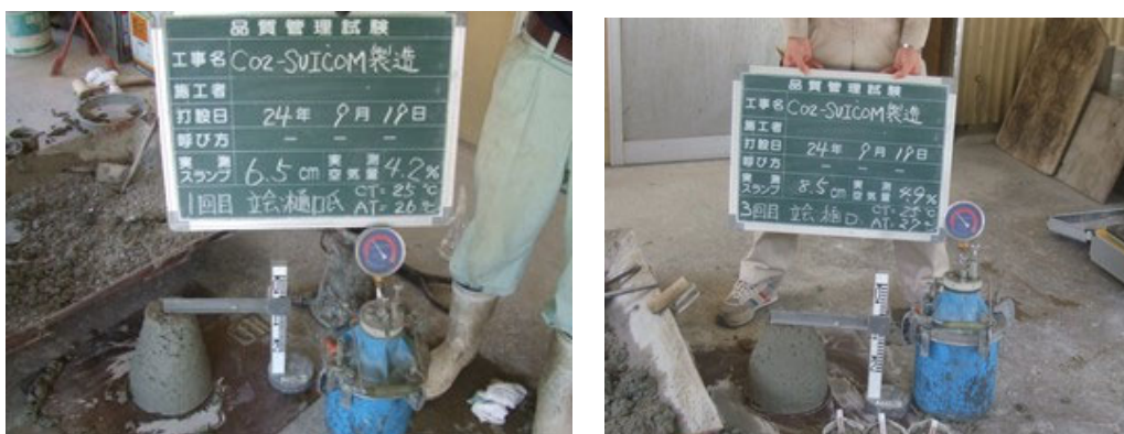
写真 6.4-2 コンクリートのフレッシュ性状
