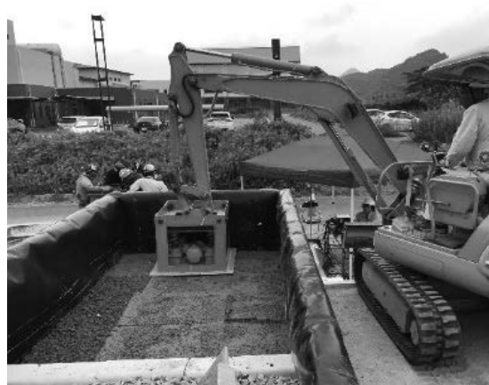
図 2 固化式処分の実証施工
