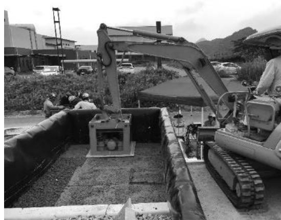
図 2 固化式処分の実証施工
