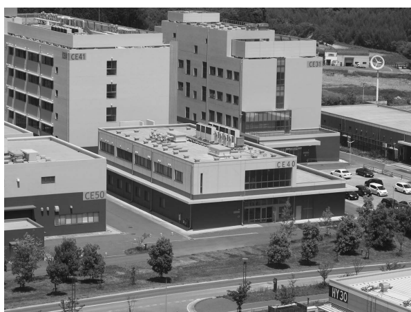
附属環境工学研究教育センター（CE40棟）外観
