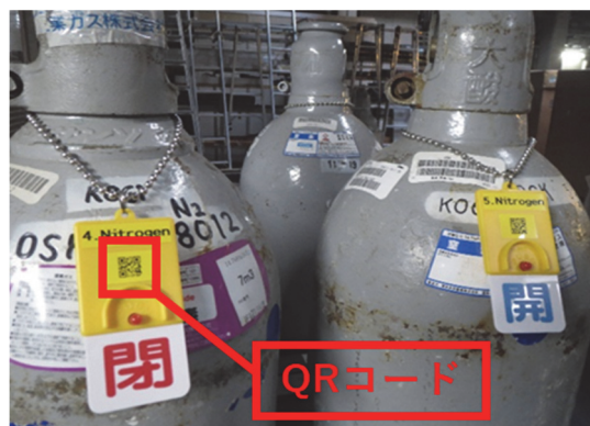
図2 開閉札を吊り下げたボンベ
