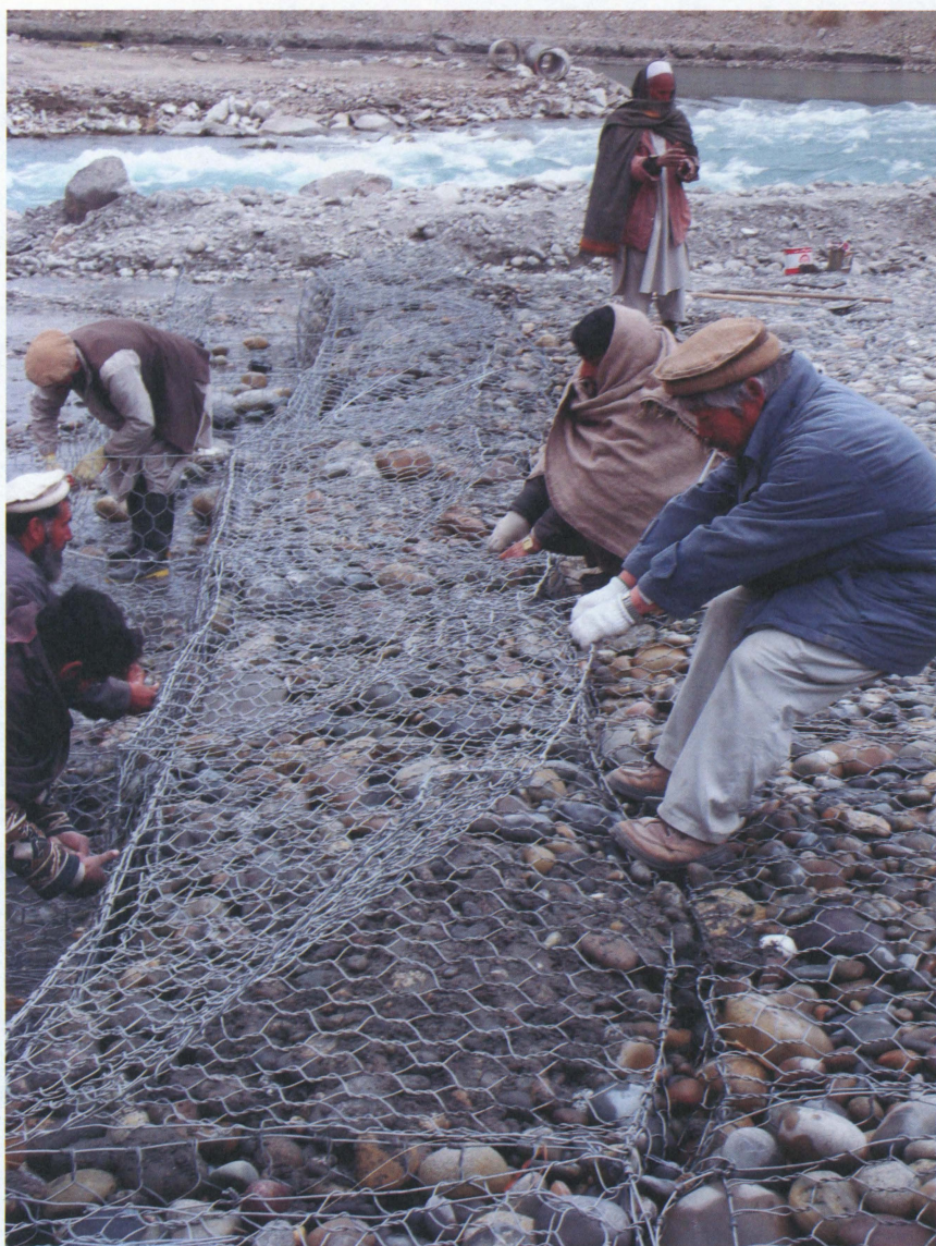
用水路護岸用の蛇籠を設置作業中の中村医師
