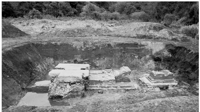
写真2・2 コンクリート蓋および煉瓦製台座〔飯塚市教育委員会所蔵〕
