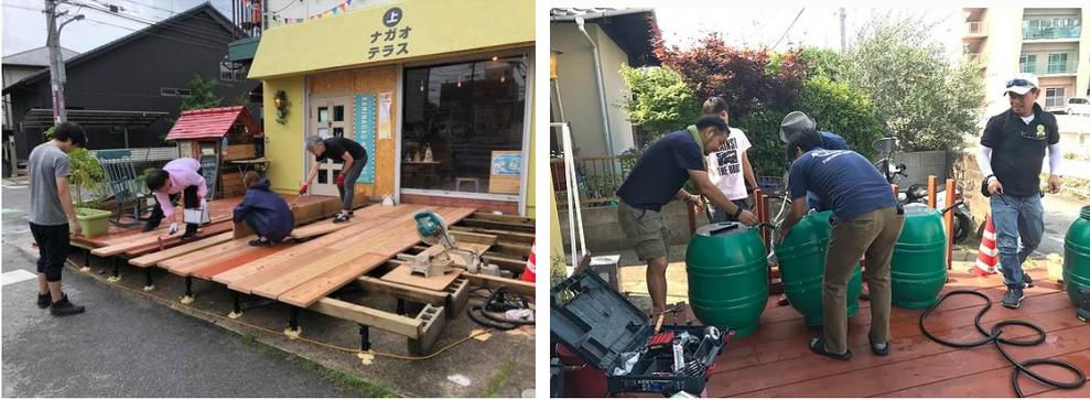
図 3-14 ウッドデッキおよび雨水タンクの設置
