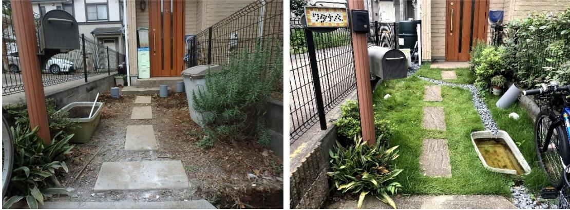
図 3-36 浸透域の改変 (左) 実装前, (右) 実装後, 水の流れ
