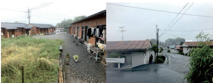
写真 3-6. 公営住宅跡地に建てられた木造仮設住宅団地 事例 3 左：木造仮設住宅 右：隣接する公営住宅
