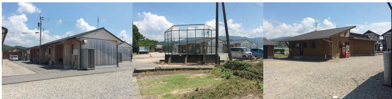
写真 3-16. グラウンドに建てられた木造仮設住宅団地 事例 1 中：グラウンドのフェンスが残っている 右：グラウンド内の施設
