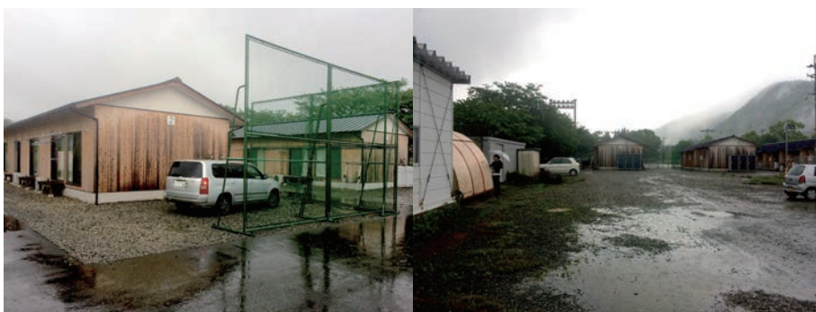
写真 3-17. グラウンドに建てられた木造仮設住宅団地 事例 2 左：グラウンドのフェンスが残っている
