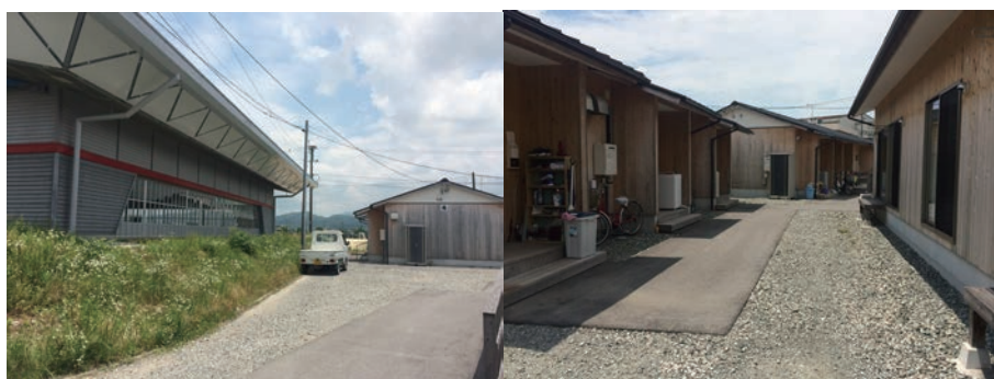
写真 3-2. 駐車場に建てられた木造仮設住宅団地 事例 2
