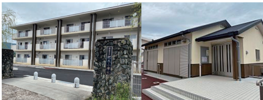
写真 6-8. 小学校跡地に建てられた災害公営住宅団地 左：校門が残る 右：団地内の集会所
