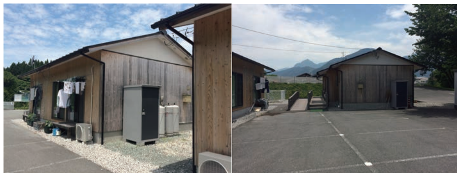
写真 3-1. 駐車場に建てられた木造仮設住宅団地 事例 1
