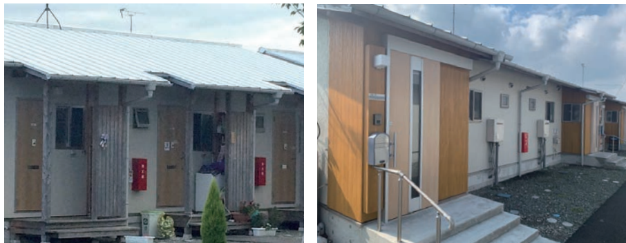
写真 5-6. 屋外洗濯機置場を内部化した事例
