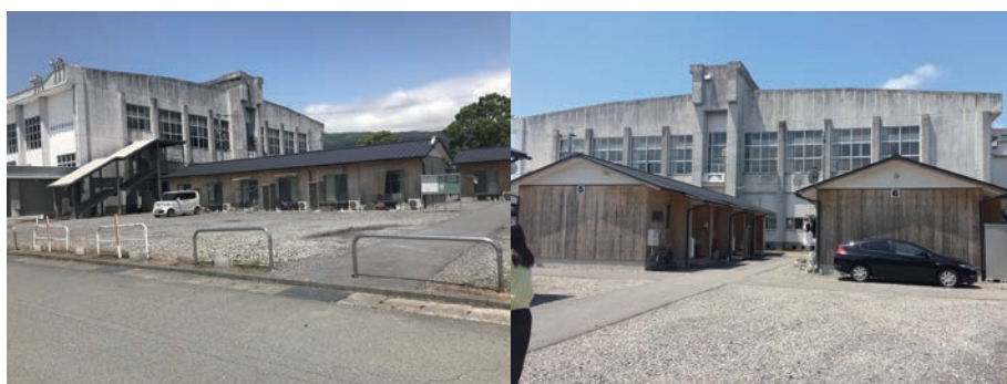
写真 3-11. 未利用公有地に建てられた木造仮設住宅団地 事例 2 体育館の敷地の一部で、体育館が隣接している
