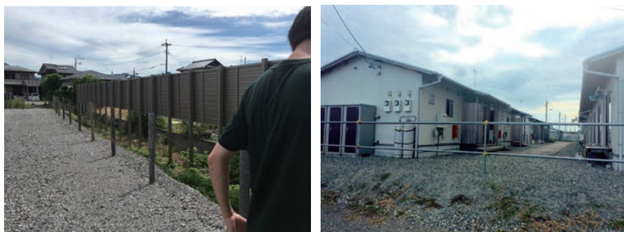
写真 5-4. 団地内のフェンス
