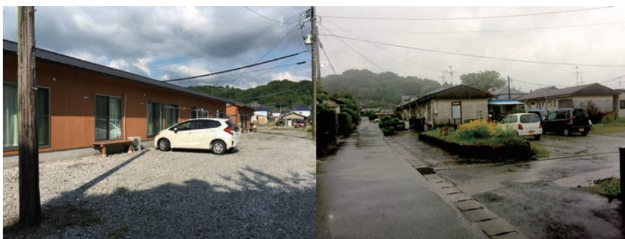
写真 3-5. 公営住宅跡地に建てられた木造仮設住宅団地 事例 2 左：木造仮設住宅 右：隣接する公営住宅
