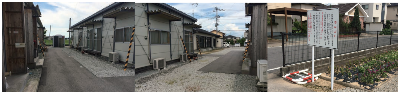
写真 3-9. 公園に建てられた プレハブ仮設住宅団地 事例 2
