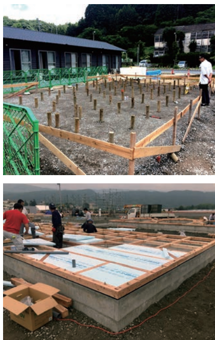
写真 1-1. 仮設住宅 従来の木杭基礎（上）と熊本のコンクリート基礎（下）
