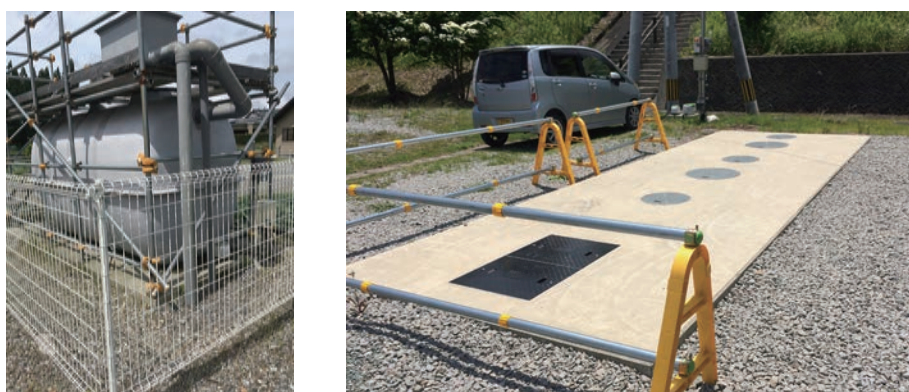
写真 5-5. 浄化槽
