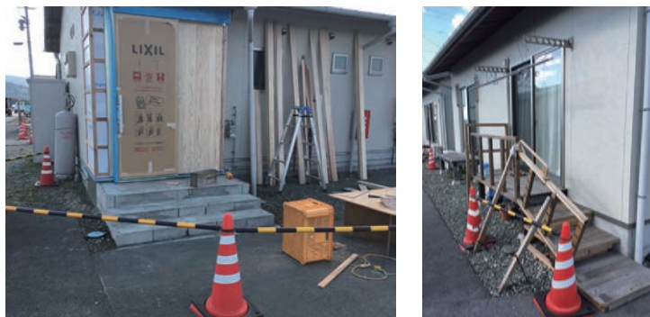
写真 5-7. 屋外洗濯機置場 改修中の様子
