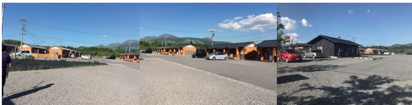
写真 3-20. 企業の土地に建てられた木造仮設住宅団地 事例 1
