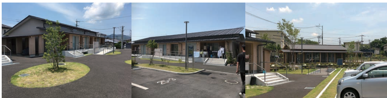
写真 4-3. UT 市 災害公営住宅団地 (図 4-8) の様子 左・中：災害公営住宅 右：集会所
