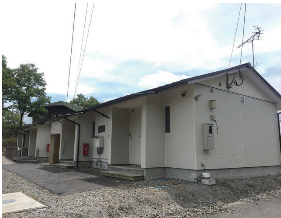
写真 5-9. 二戸一化を行った事例 外観
