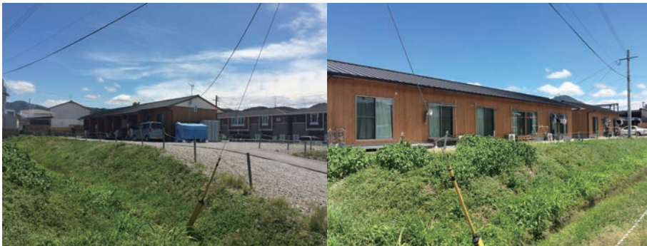
写真 3-14. 農地に建てられた木造仮設住宅団地 事例 2 敷地を嵩上げて建てられている
