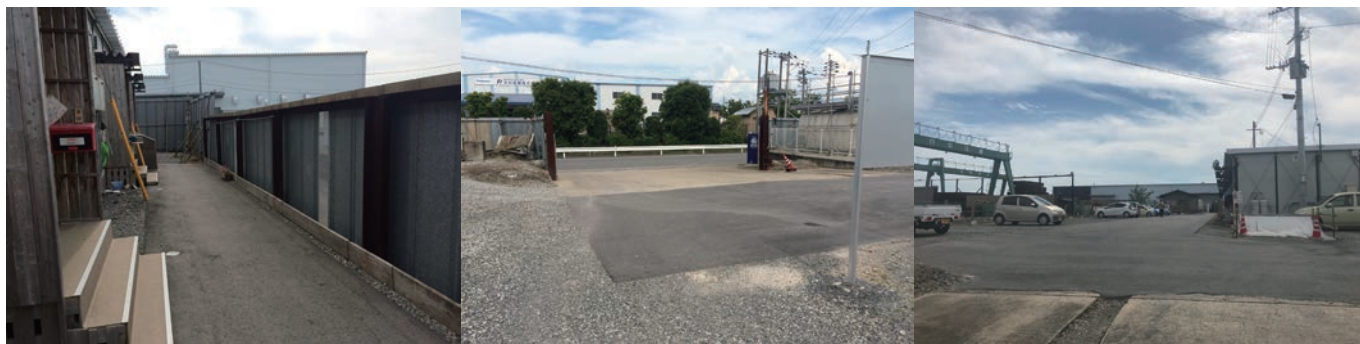
写真 3-19. 企業の土地に建てられたプレハブ仮設住宅団地 事例 1
