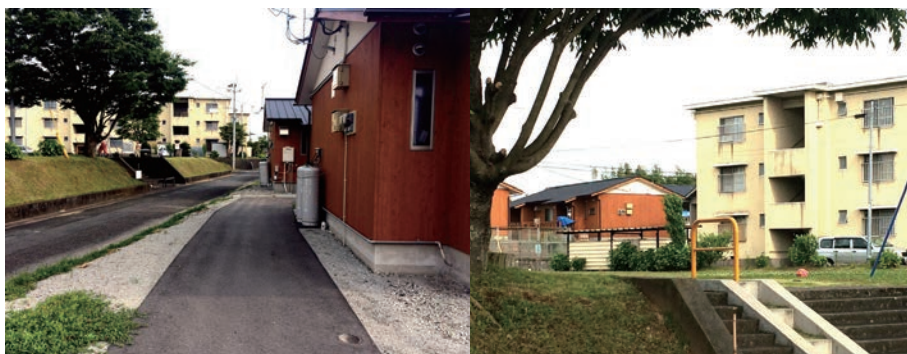
写真 3-4. 公営住宅跡地に建てられた木造仮設住宅団地 事例 1 鉄筋コンクリート 3 階建ての公営住宅が隣接している
