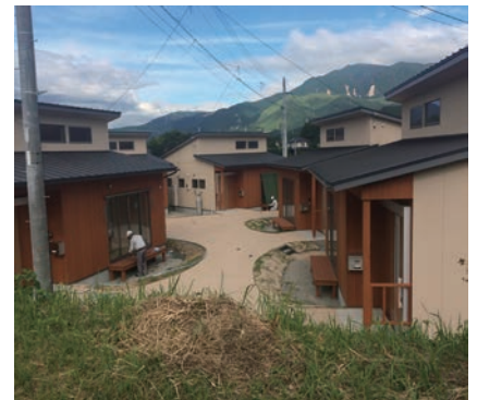
写真 4-8 N村災害公営住宅
