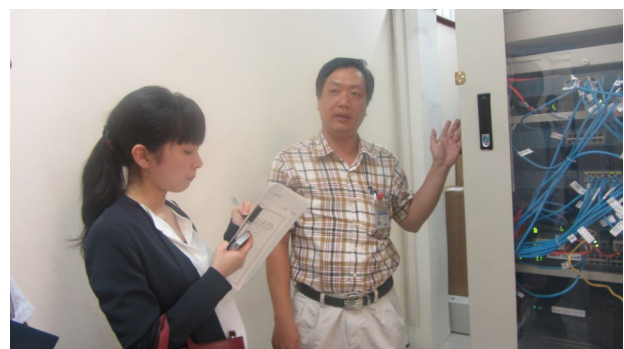
サーバールーム
