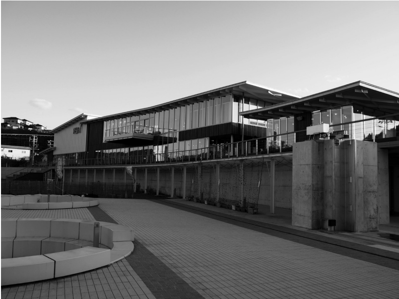
図5 公共施設と組み合わせた防潮堤（2019年10月9日撮影） 撮影者：高田亜沙里
