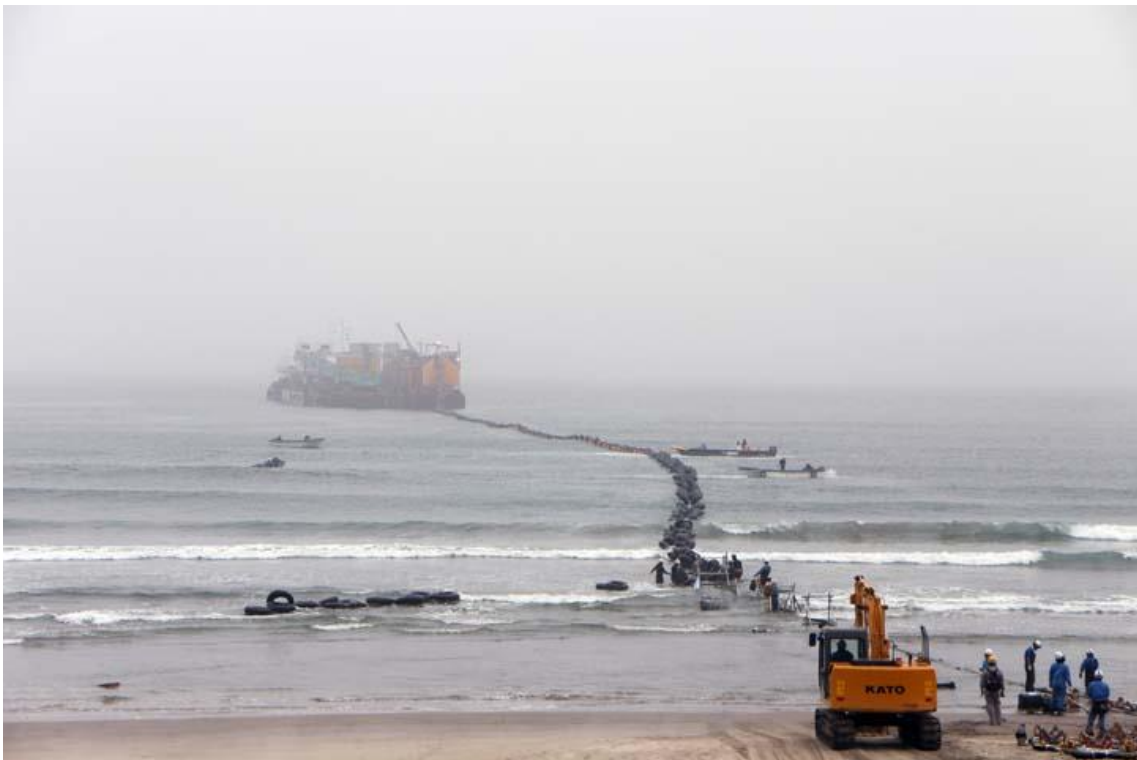
図 1-1 洋上風力発電用海底送電ケーブル敷設 [1]
