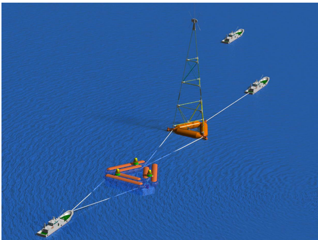
図 1-7 曳航運搬時の余剰浮力で浮いた状態
