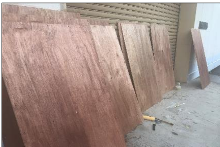
Figure3.3.4 防水塗料を塗布している様子
