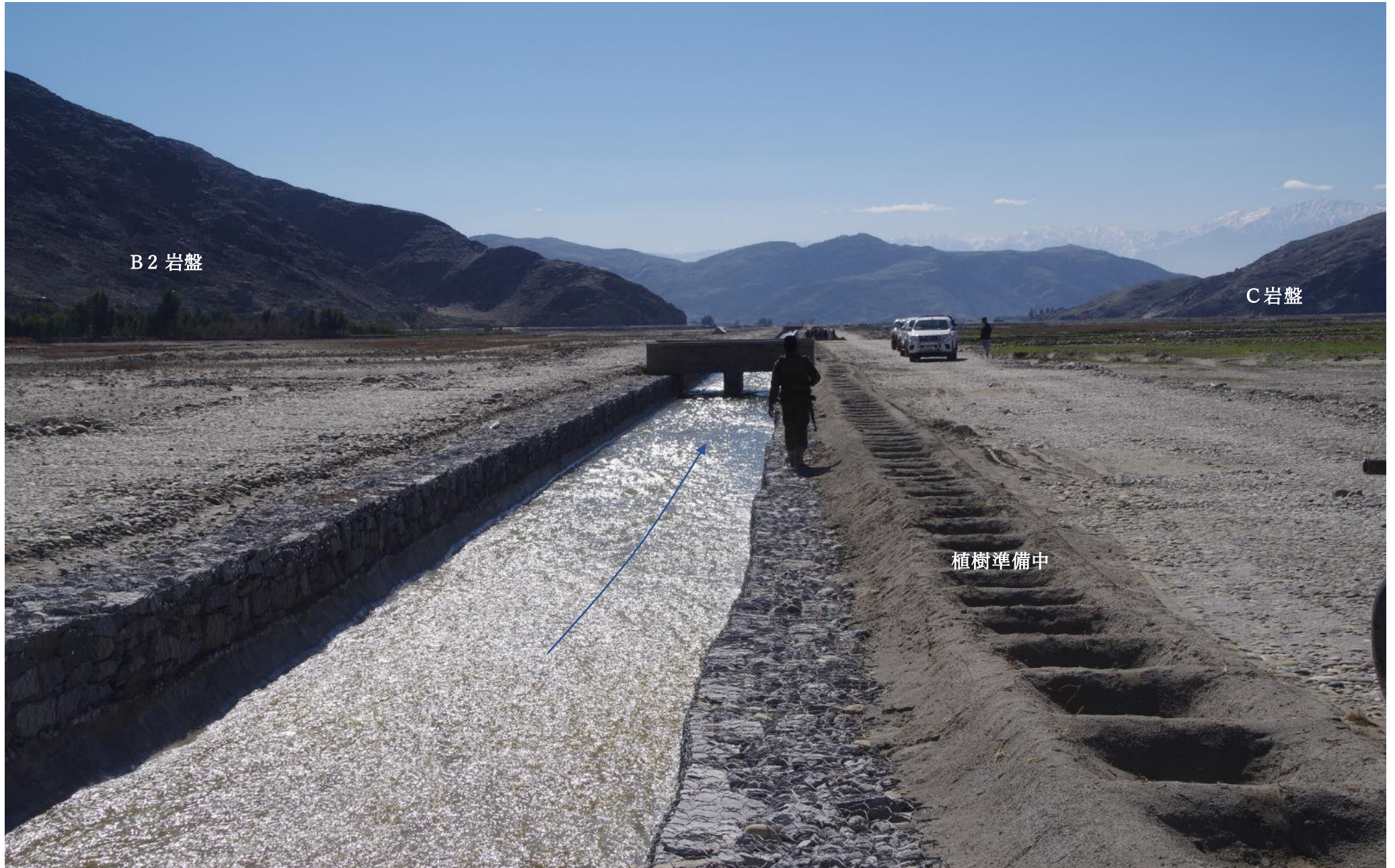
用水路B区。約 2.5 km地点。植樹準備中。2018 年 2 月 22 日
