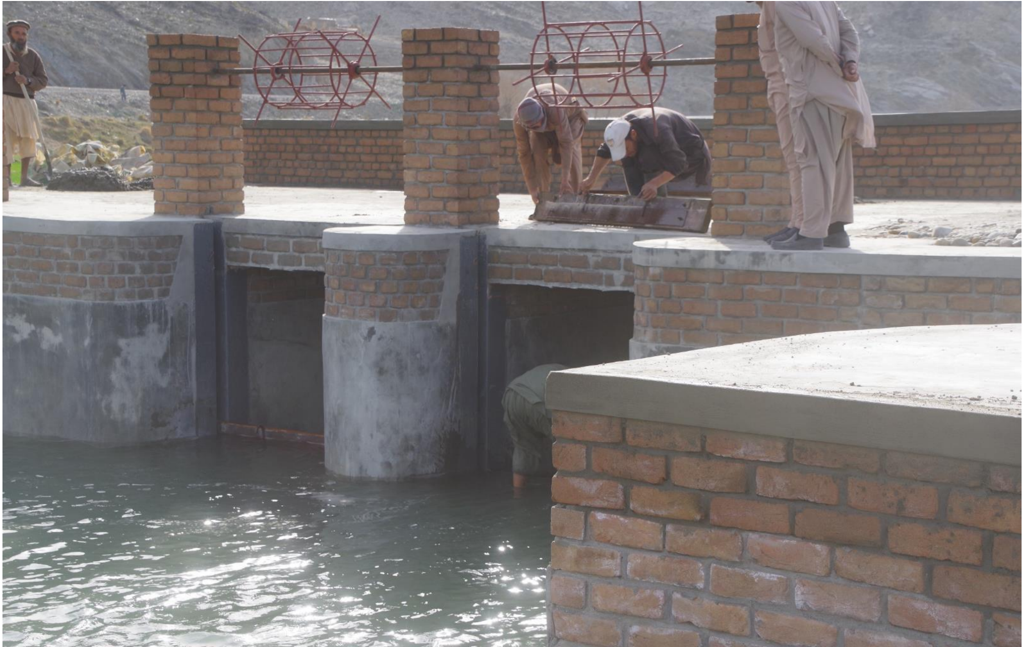
2月22日、調節池Ⅲ、初めて主幹水路の送水門を開ける。2018年2月22日
