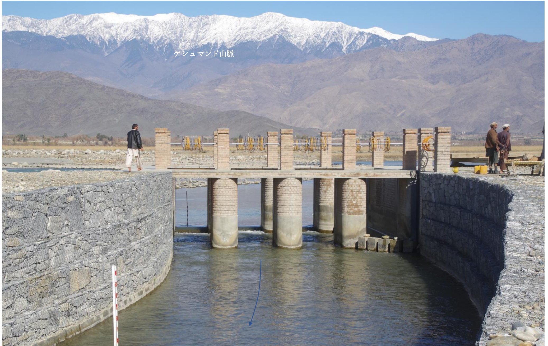
取水門の現在。水位 40 cm、超低水位だが、十二分の取水ができています。2018 年 2 月 22 日
