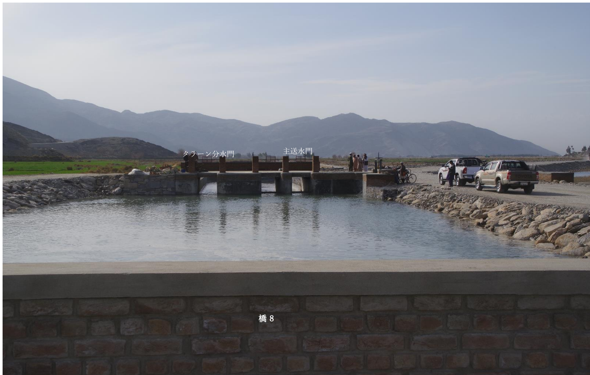
2018年2月22日 送水試験のために水をたたえる調節池Ⅲ。上流側から見る。
