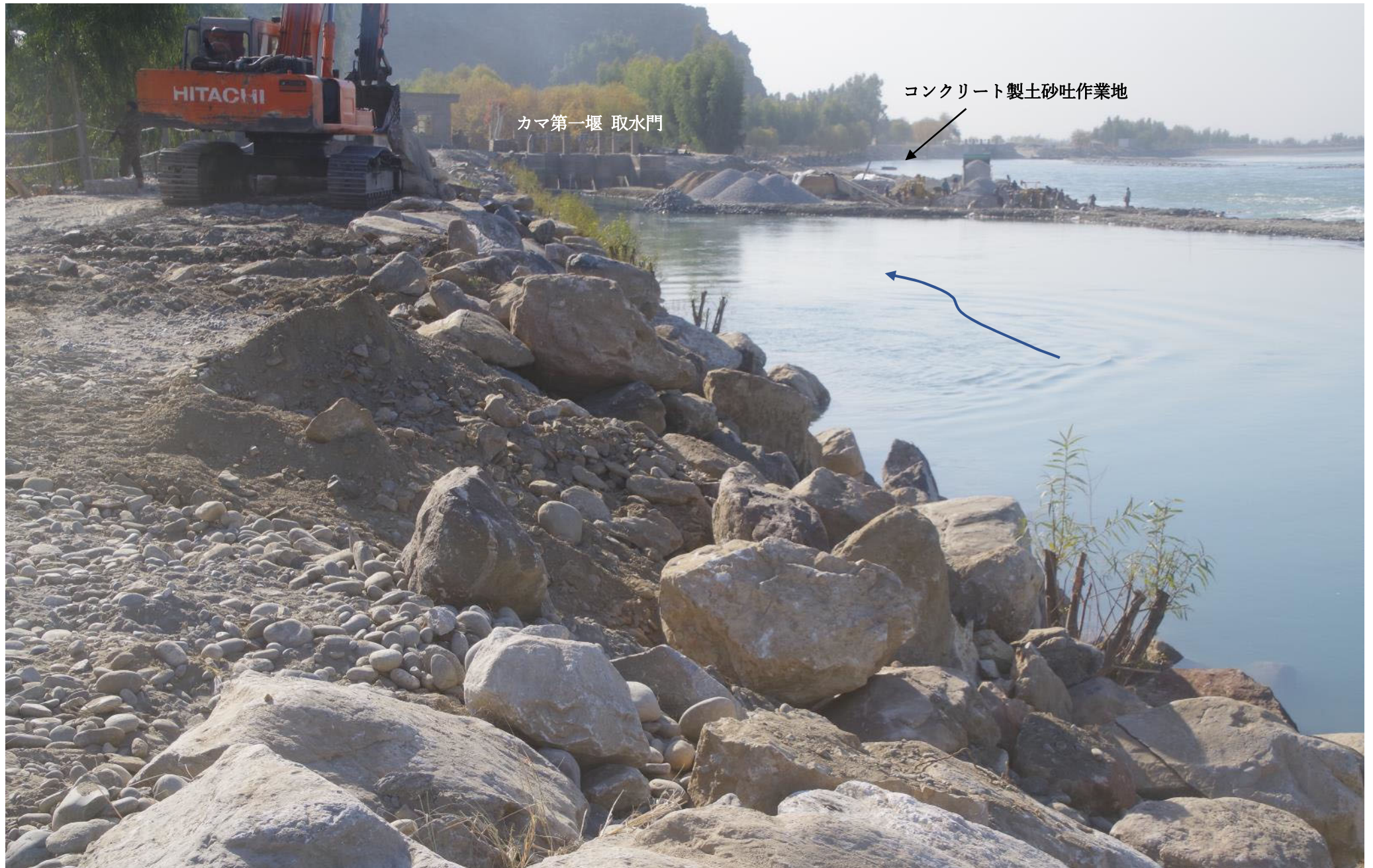
左岸、取水口より上流側の護岸。堰全体がよく見渡せる。堰上げに伴うかさ上げ。2018年12月25日
