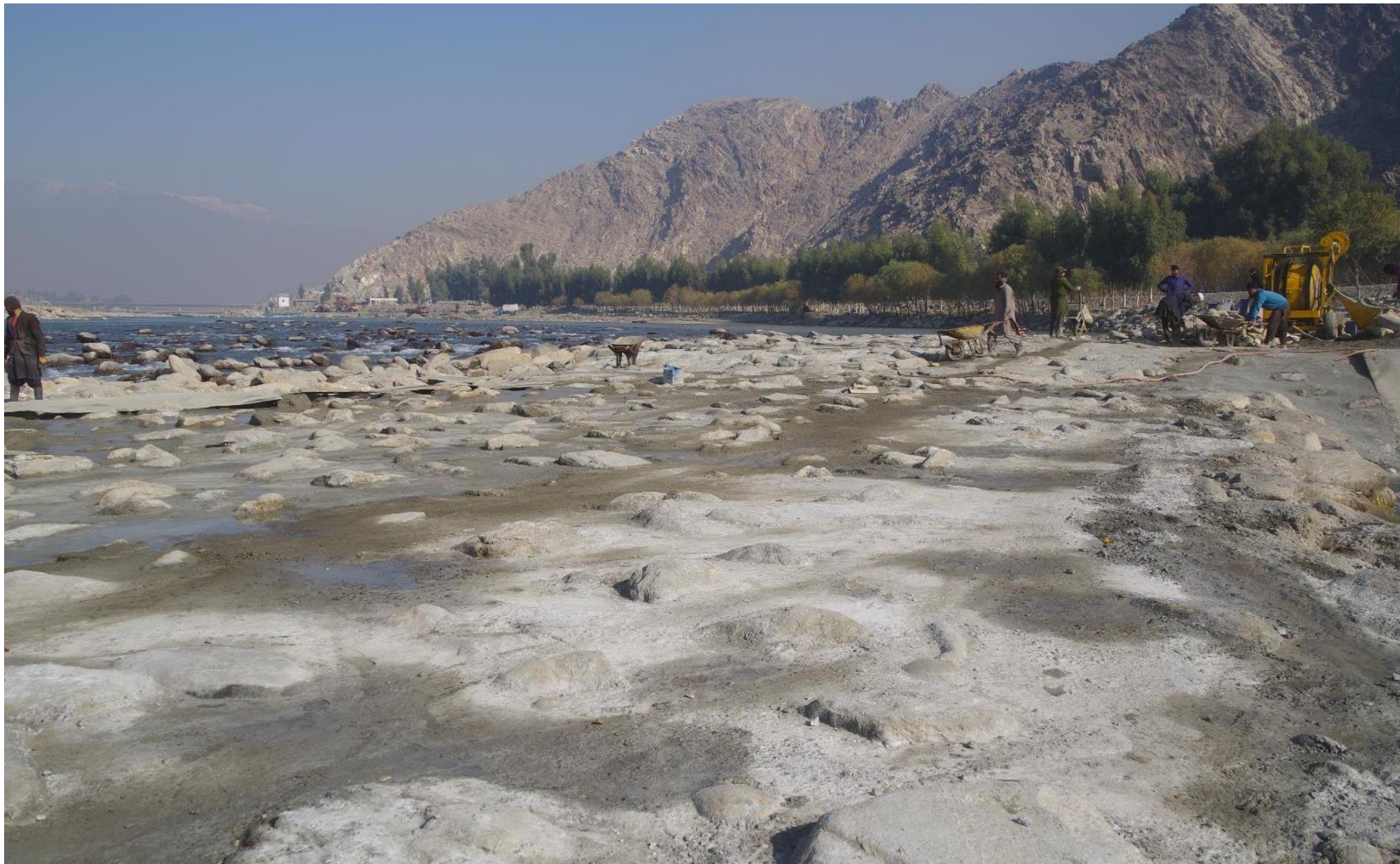
カマ第二堰。砂吐＝堰の接合部は練石積みにして強化、増水期に最も激しい流れが通過する。だんだん今の山田堰に似てきている。2018 年 12 月 20 日
