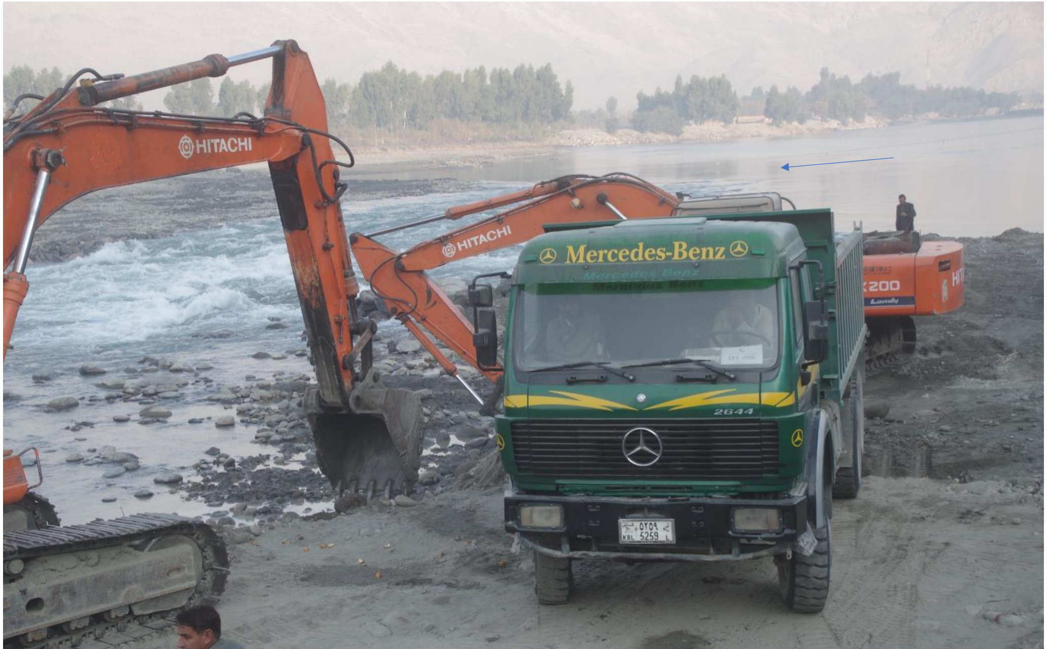
砂吐基礎(部分可動堰)の工事風景。基礎工事は浸透水との戦いで、厳冬期でないとできない。2018 年 12 月 3 日
