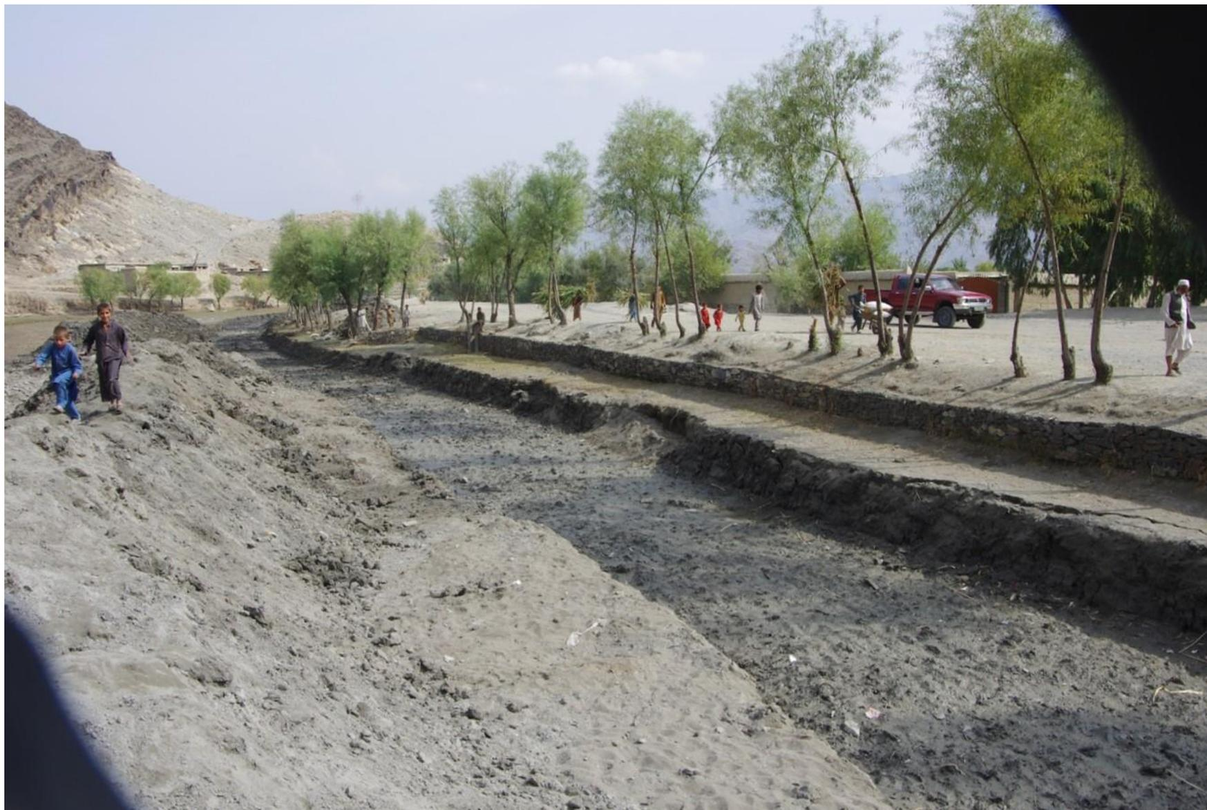
ガンベリ横断路の浚渫。黒い泥土が堆積している。有機物を含み、肥料として貴重品。2018年10月16日
