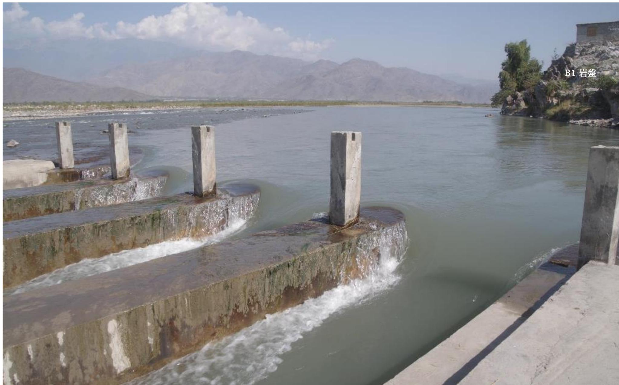
堰体表面の砂利は洗い流され、巨礫間を詰め、堰体が安定している。巨礫が堰表面に露出しているが各部の傾斜、洪水吐は良く保たれて機能している。表面の損壊は殆ど観察されない。2018年10月18日
