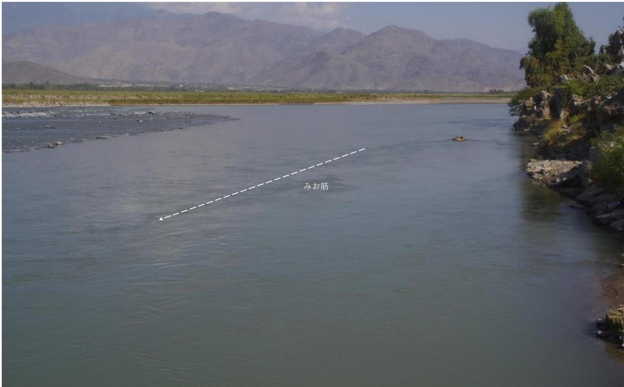
堤防約 6 km地点。水制間隔 25m、各水制長 30m前後。激しい攻防を繰り返し、先端に相当な巨礫が投入された。この 4~6 kmの区間は、川の傾斜が最も急なうえに湾曲部外縁に当たり、水制先端に激しい洗堀が起きた。2年を経て安定し、深い河道を形成した。(次図参照) 予定は、このような堤防を強化しながら、更に 2.5km延長、ミラーン対岸に至り、両岸から河道整備を進めれば、ミラーン堰が安泰となる。本法がクナール河での浸食防止策として定着した。
