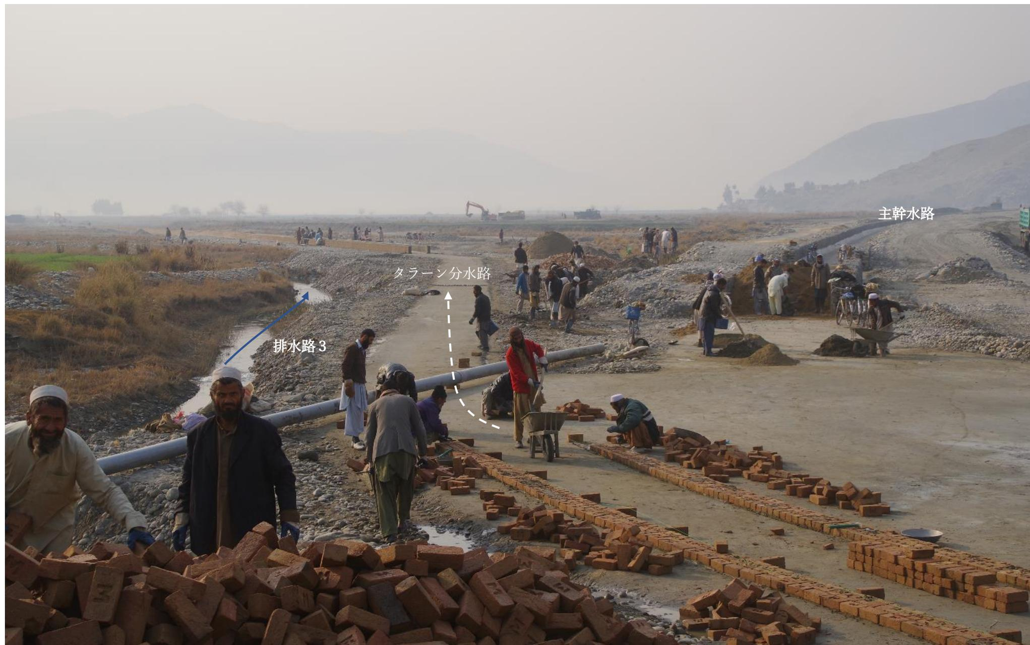
タラーン分水路はソイルセメント・ライニングの上にレンガ壁を積んで作る。傾斜が急なので、毎秒  $1.0 \text{ m}^3$  は優に流せる。2018 年 1 月 24 日
