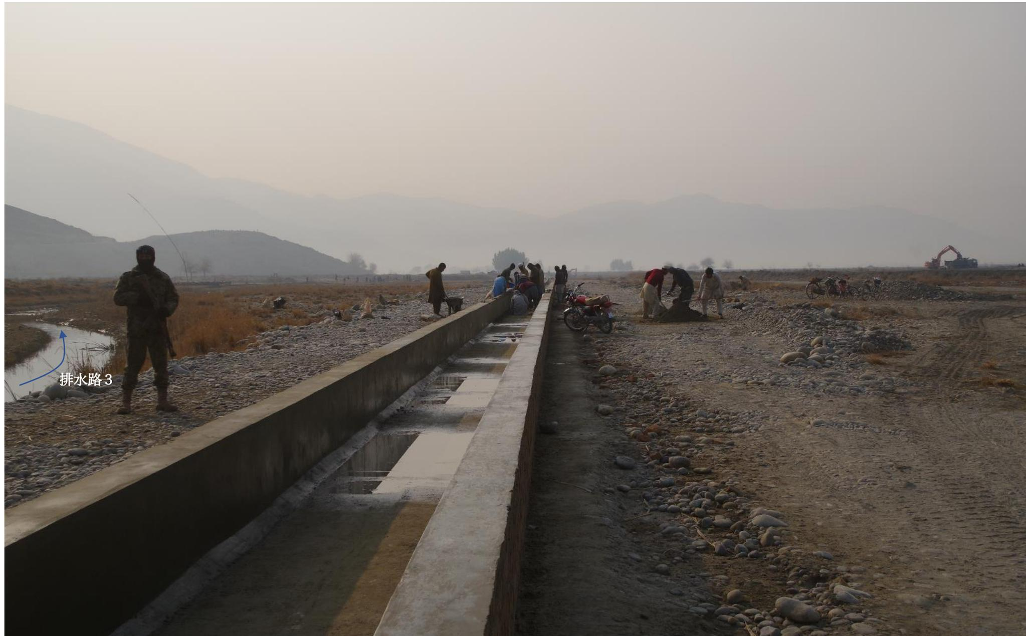
調節池IVに到着した主幹水路。河側堤防は幅約 15m 前後で、更に高くされる。最後の橋 9 の建設中。2018 年 1 月 24 日
