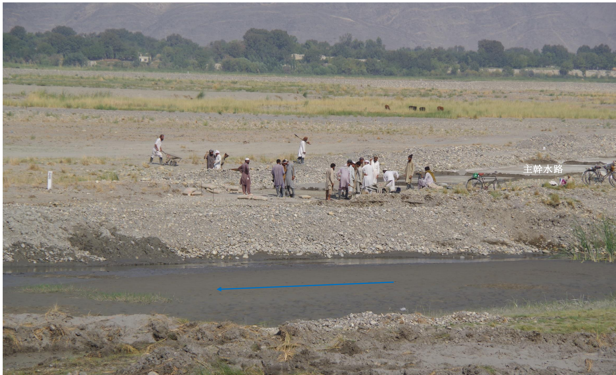
3100m地点のライニング。10月8日に調節池の手前まで達し、翌9日よりグループは調節池周囲の工事に入った。2017年10月8日
