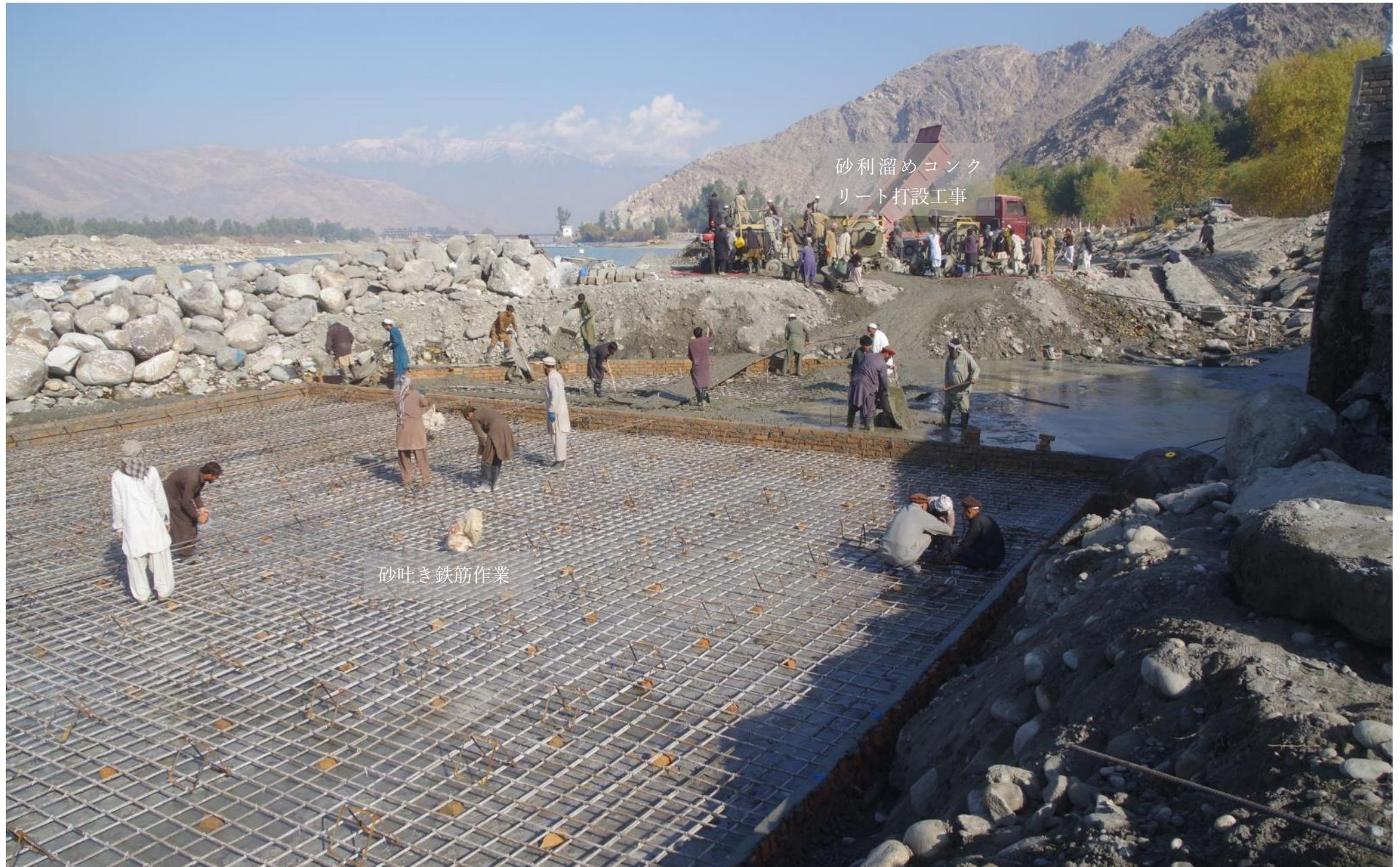
浸蝕された堤防の基礎は巨礫または岩盤の層までコンクリート床面を連続、作業場で溜めた鉄筋の切れ端を集めて鉄筋のジャングルを埋め込む。コンクリートを入念に充填すれば、強力な岩塊となる。
