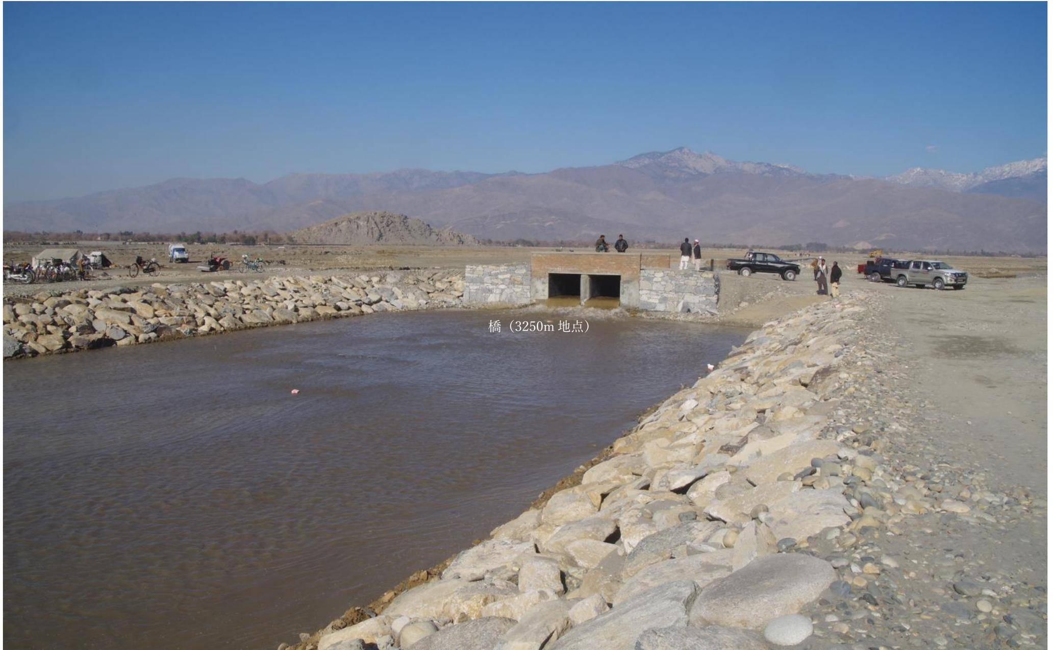
サイフォン。排水路の水は調節池 I と II で調整されていて、普段は少ない。夏季の山沿いで発生する鉄砲水の流路となる。サイフォン釜場間の距離は 20m、周囲の石垣はまだ高くなり、下流側は調節池 III の外壁堤防と連続される。
