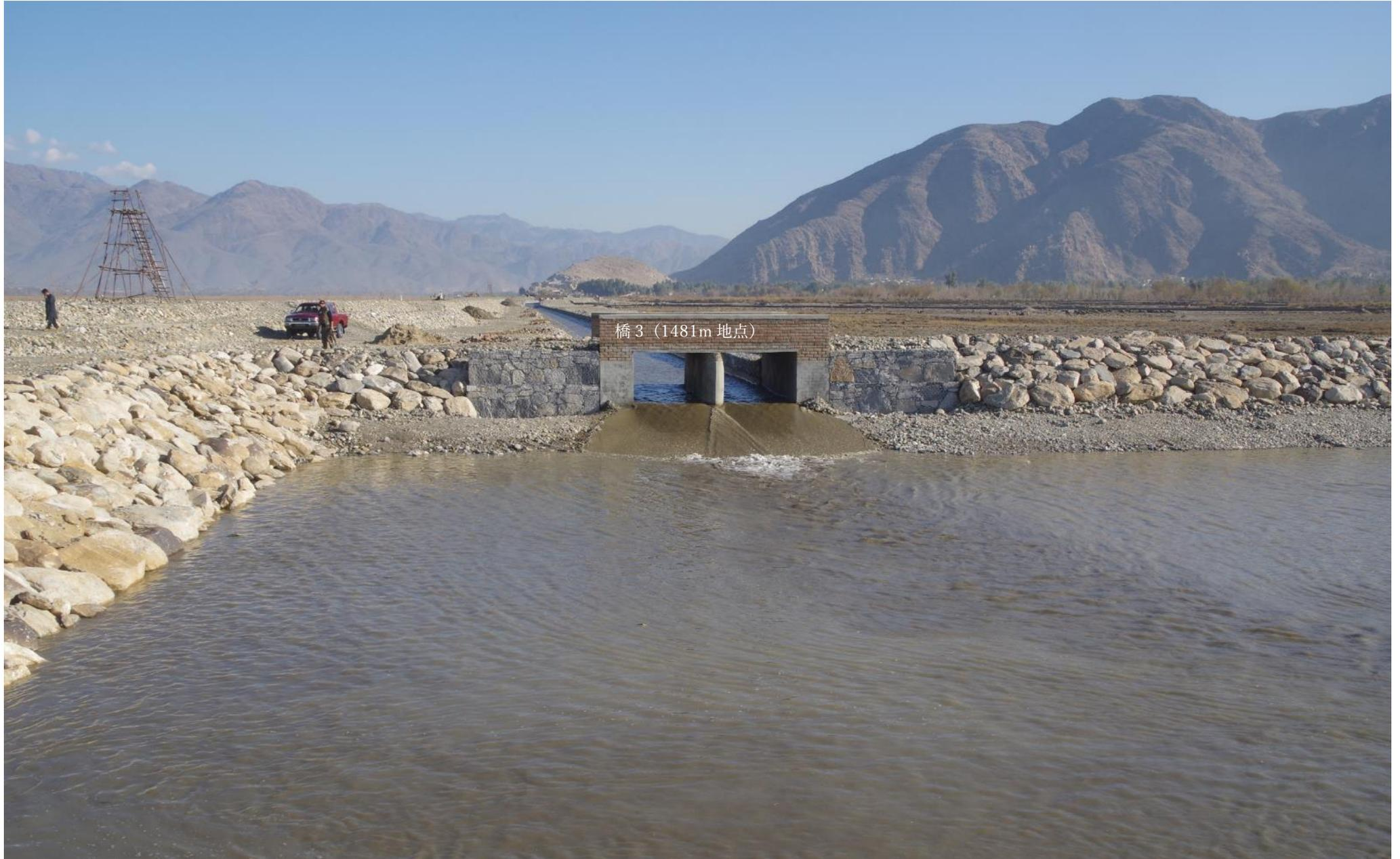
満水直前の調節池Ⅱ。池には送水門がない。水量調節を専ら調節池Ⅰに一本化するため、排水門だけが備えてある。この下流側から調節池Ⅲまでが用水路B区で、約1640m。
