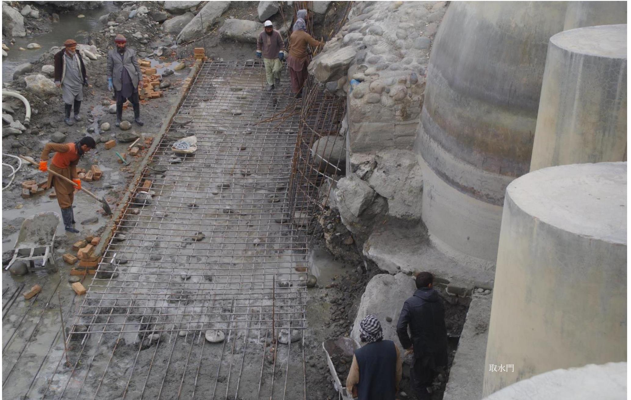
中洲への橋を下流側から見る。コンクリート打設工事は終了、全作業員はカマ側に移動している。今週中に河道Ⅱを開放し、河道Ⅰの水位を下げる。橋は夏には水没し、水位が高くなると水制のように働き、先端に洗堀が起きる。それを防ぐため、橋先端を中洲の高い位置に埋設して連続させる
