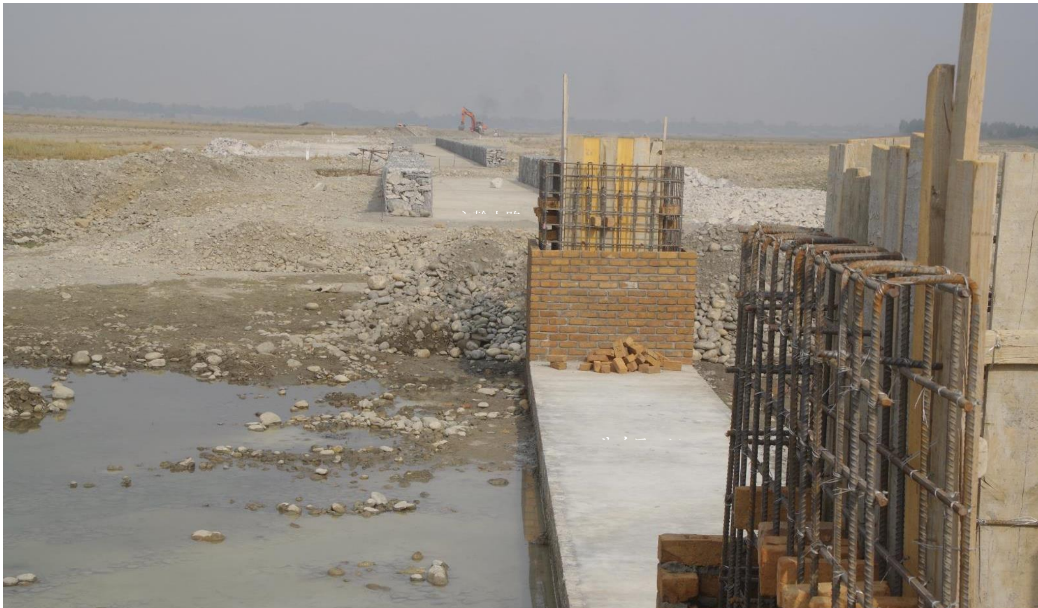
サイフォンから上流側を望む（工事のため、排水路は別ルートで排水している）。2017 年 11 月 14 日
