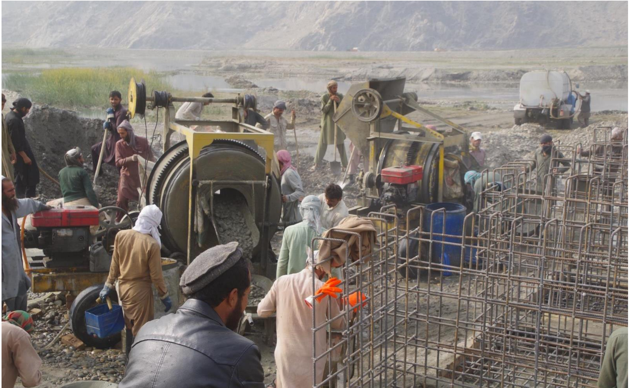
コンクリート構造物は多いが、皆元気がいい。調節池Ⅲの送水門工事。（動画あり）2017年11月14日
