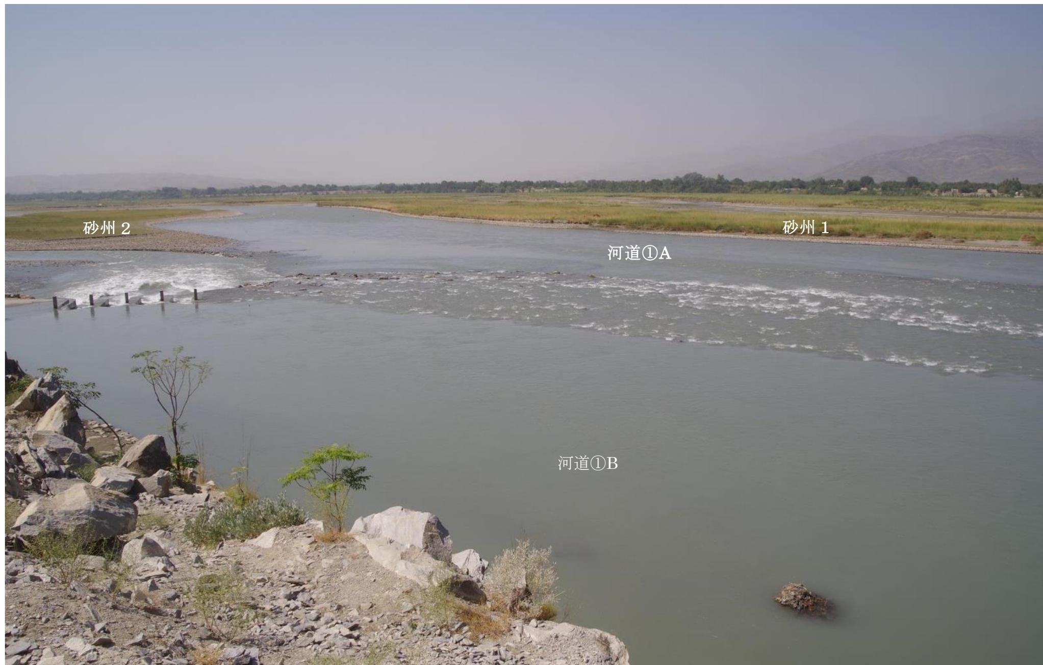
写真3. 堰中央部。浅い越流水深を維持して、殆ど形を変えていない。2017年9月26日
