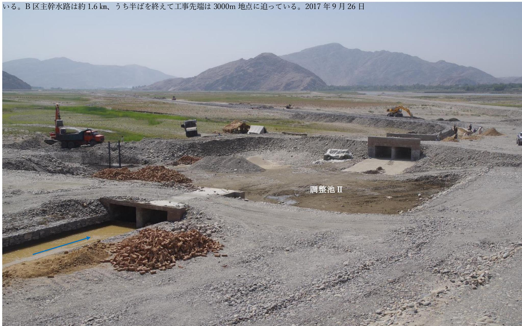
調節池 II と強化堤防区との位置関係を示す。大洪水時には、本堤防が障壁となって破壊的な流速を和らげる。
