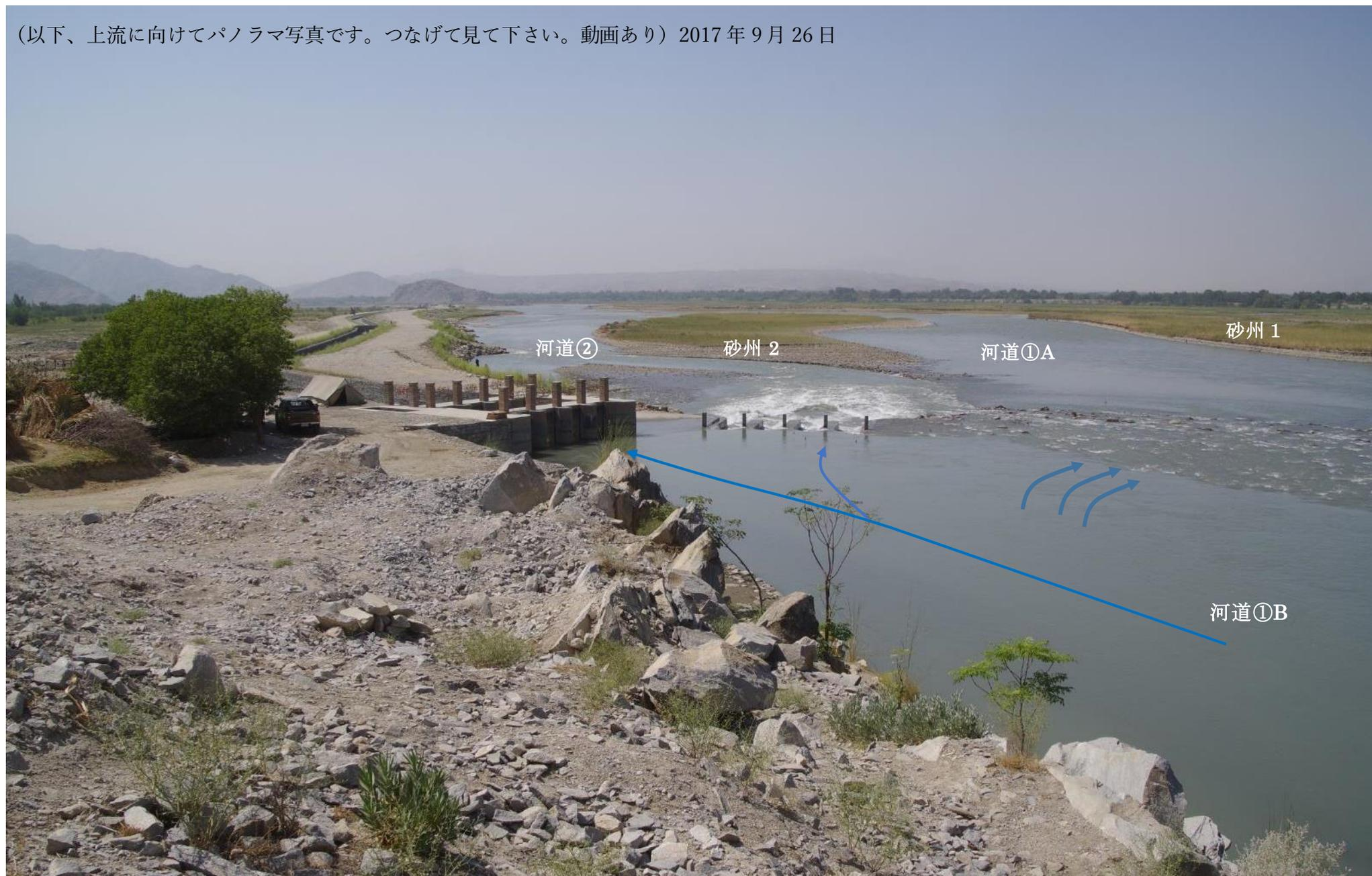
写真2. 堰下流部。岩盤沿いのみお筋は、そのまま直進して固定堰へ向かい、堆積はない。2017年9月26日
