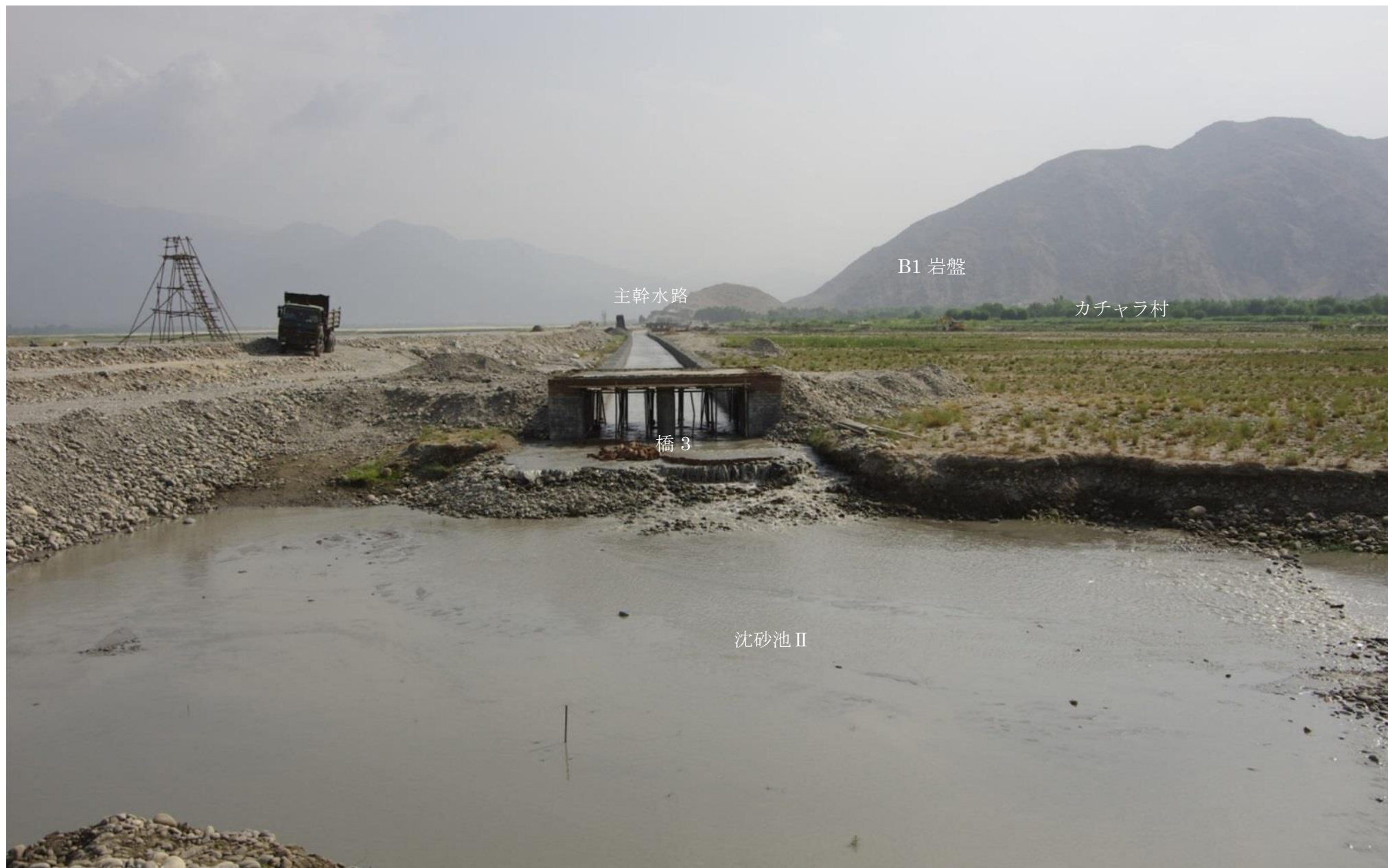
沈砂池Ⅱの下流側から上流を望む。沈砂池Ⅰからの主幹水路 500m が開通している。2017年8月13日（ザイヌッラー撮影）
