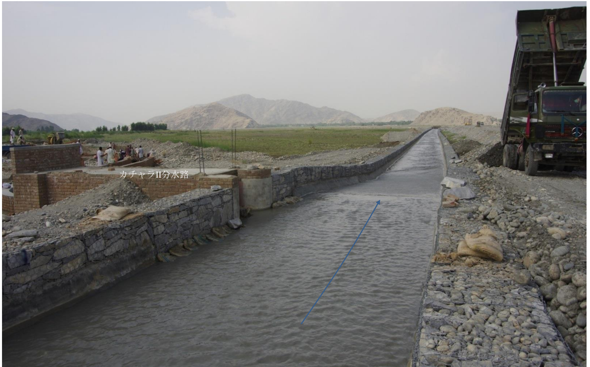
カチャラⅡ分水路。ひと月前に取水部が完成し、現在分水路本体を工事中。2017年8月13日（ザイヌッラー撮影）
