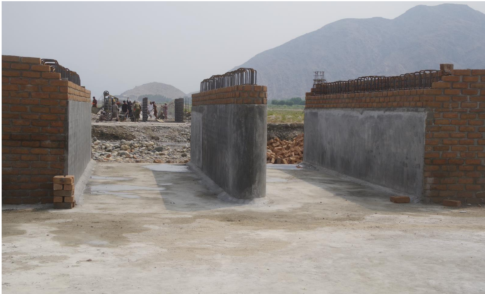
調節池Ⅱ下流側の橋4は橋脚を完成し、いつでも水が通過できる。2017年7月22日
