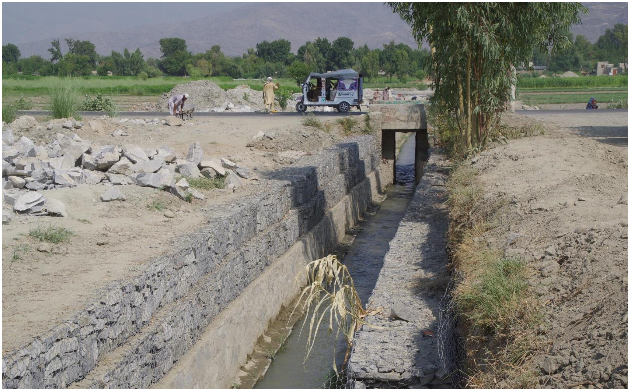
ガンベリ主幹排水路、1100m 地点。上流 1 kmは完工、残すは下流約 700m の籠積みだけとなった。2017 年 7 月 24 日
