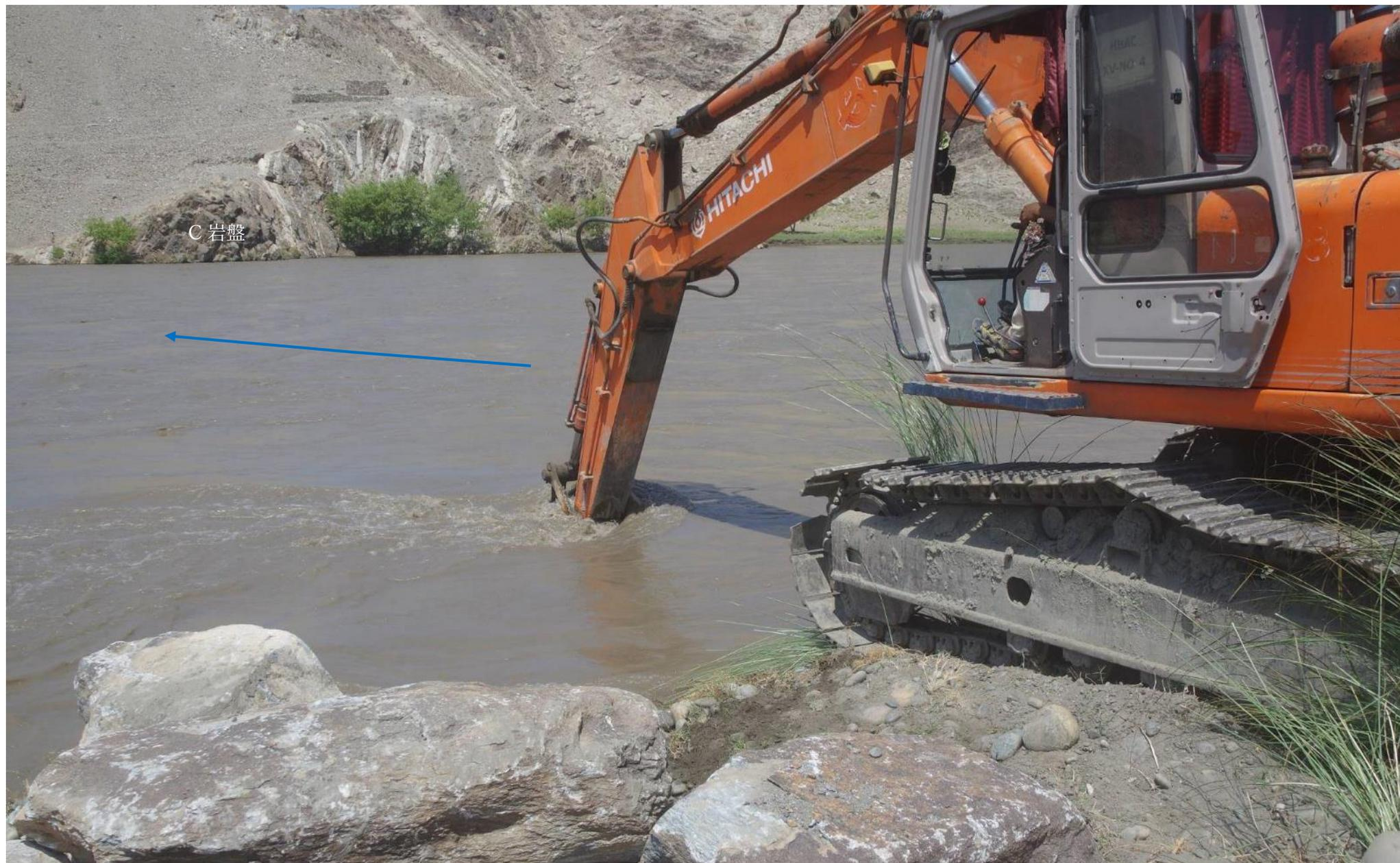
4.8 km地点（分流発生点）の現在。浸透水が減り、川側の斜面（表法）の強さに不安はないが、決壊は悪夢だ。裏法は補強が要る。基本的に 1500m 地点と
