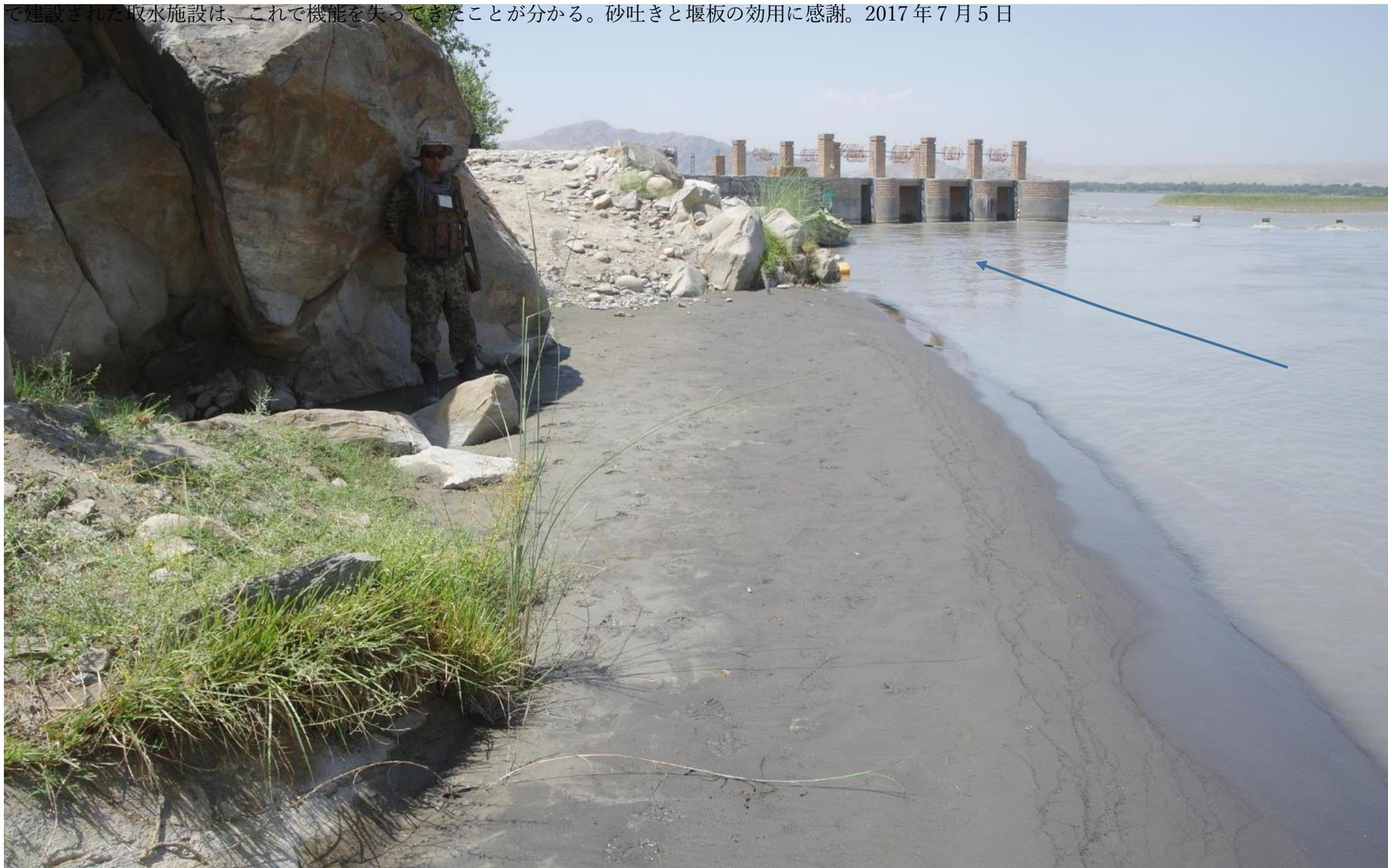
1500m 地点、「特別堤防」の基礎工事。何が特別かといえば、堤体幅の厚さと基礎の頑丈さだ。中に巨礫の水制が埋め込まれ、さらに川側に根固め工が施される。最終的な幅は約 80m で、ガンベリ沙漠横断路の Q2 貯水池の堤防に次ぐ。過度に高くせず、大洪水時に流入量を減らし、流速を減殺することを目的にする。堤体は粘土質のものは使わず、粒径の大きな砂利を使い、根気よく水を注いで砂を石の空隙に詰めていく。両側斜面に樹林帯を作る。
