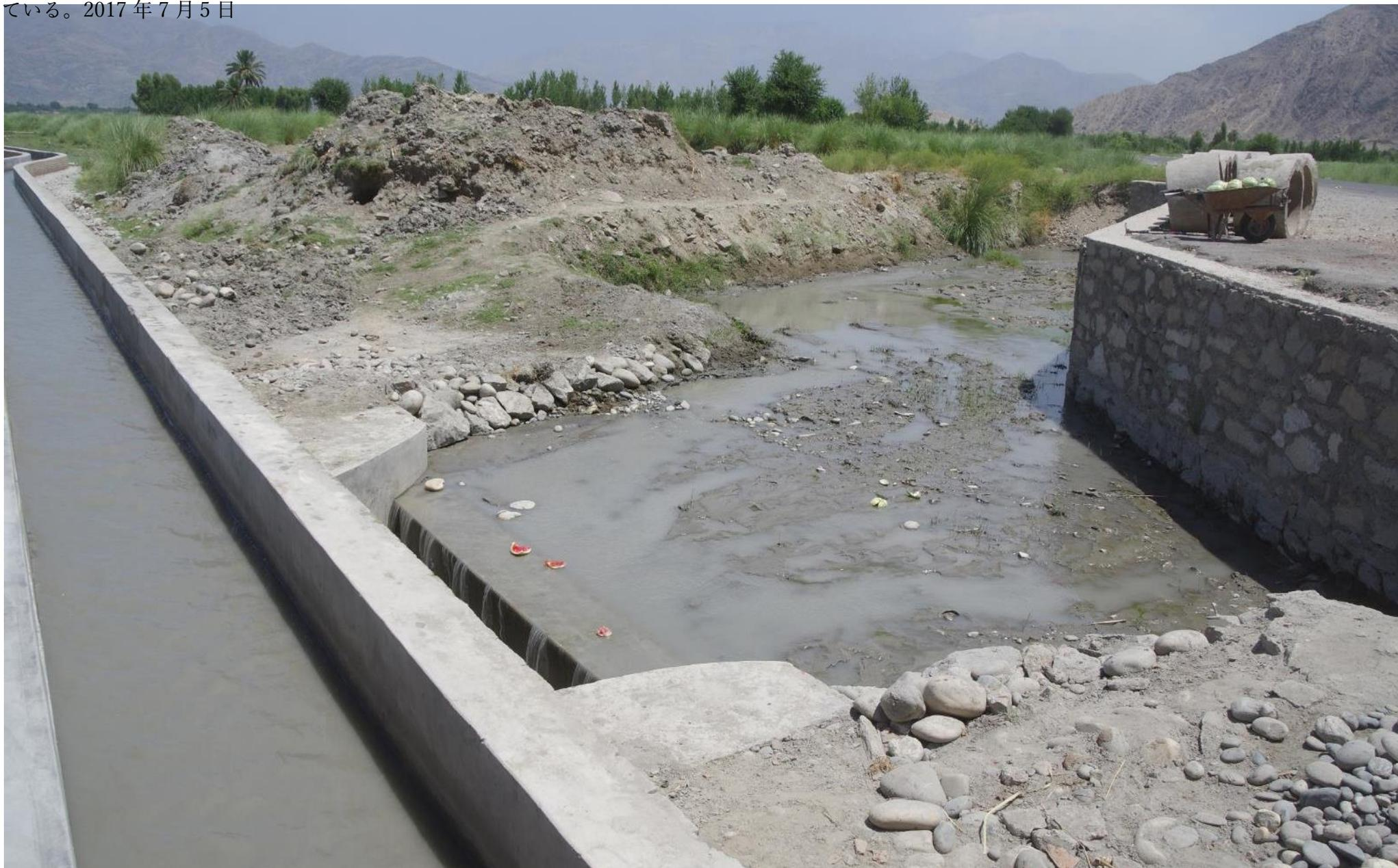
用水路沿いに簡易道路を敷設し、小さな橋が架けられている。排水路1はカチャラ用水路Iからの排水、降雨時の余水、浸透水などを集めて流れ、3.6 km地点でクナル河に戻る。一部が排水路3に取り込まれてコーティ用水路となる。2017年7月5日
