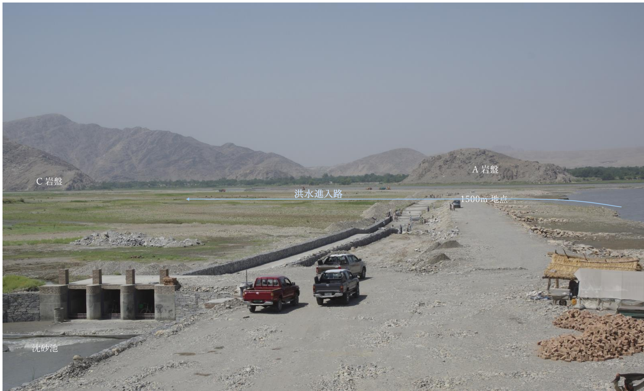
洪水浸入 1500m 地点の遠望。2017 年 6 月 12 日
