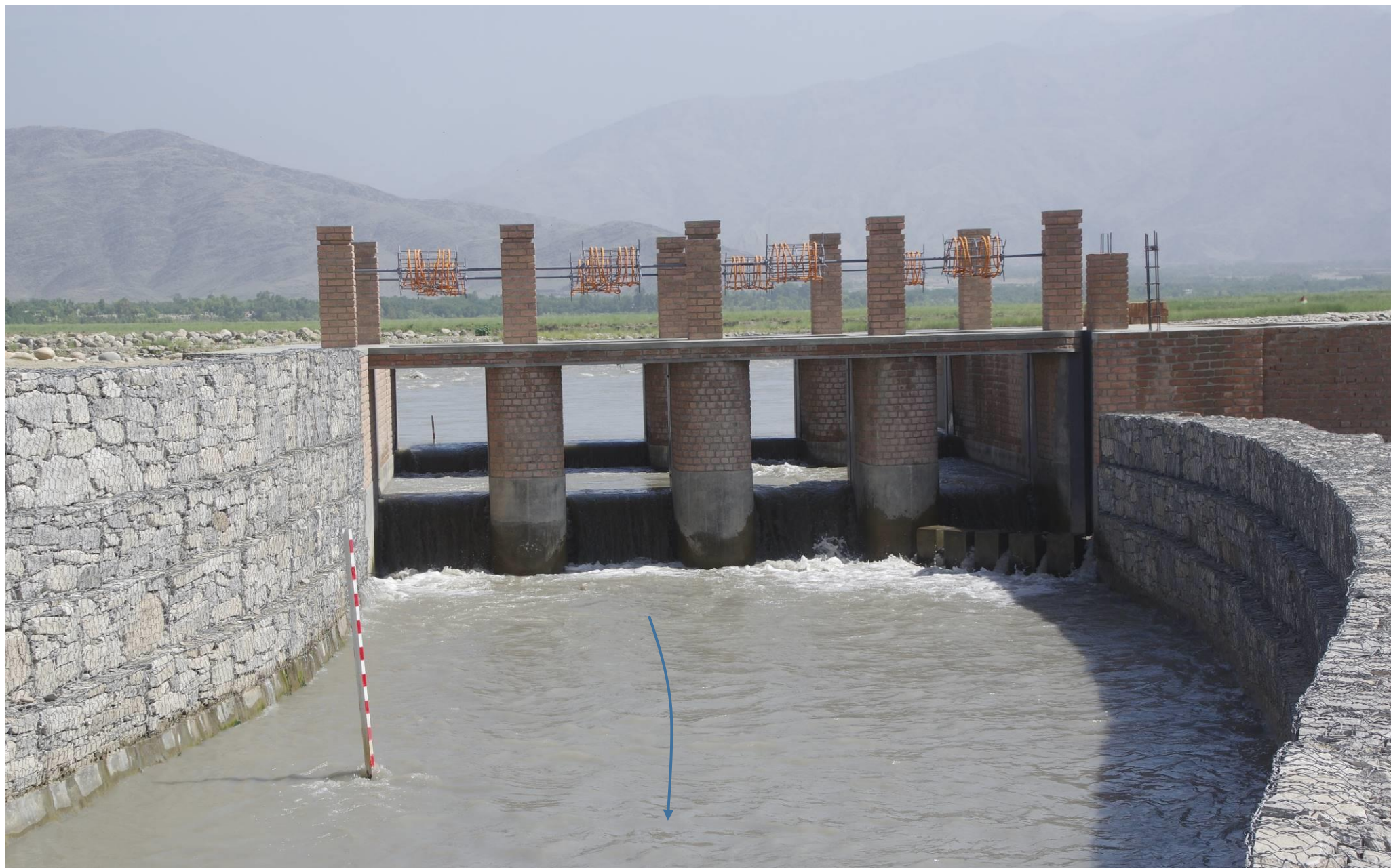
取水門下流側。おなじみの二重堰板方式。(動画あり) 2017年6月12日
