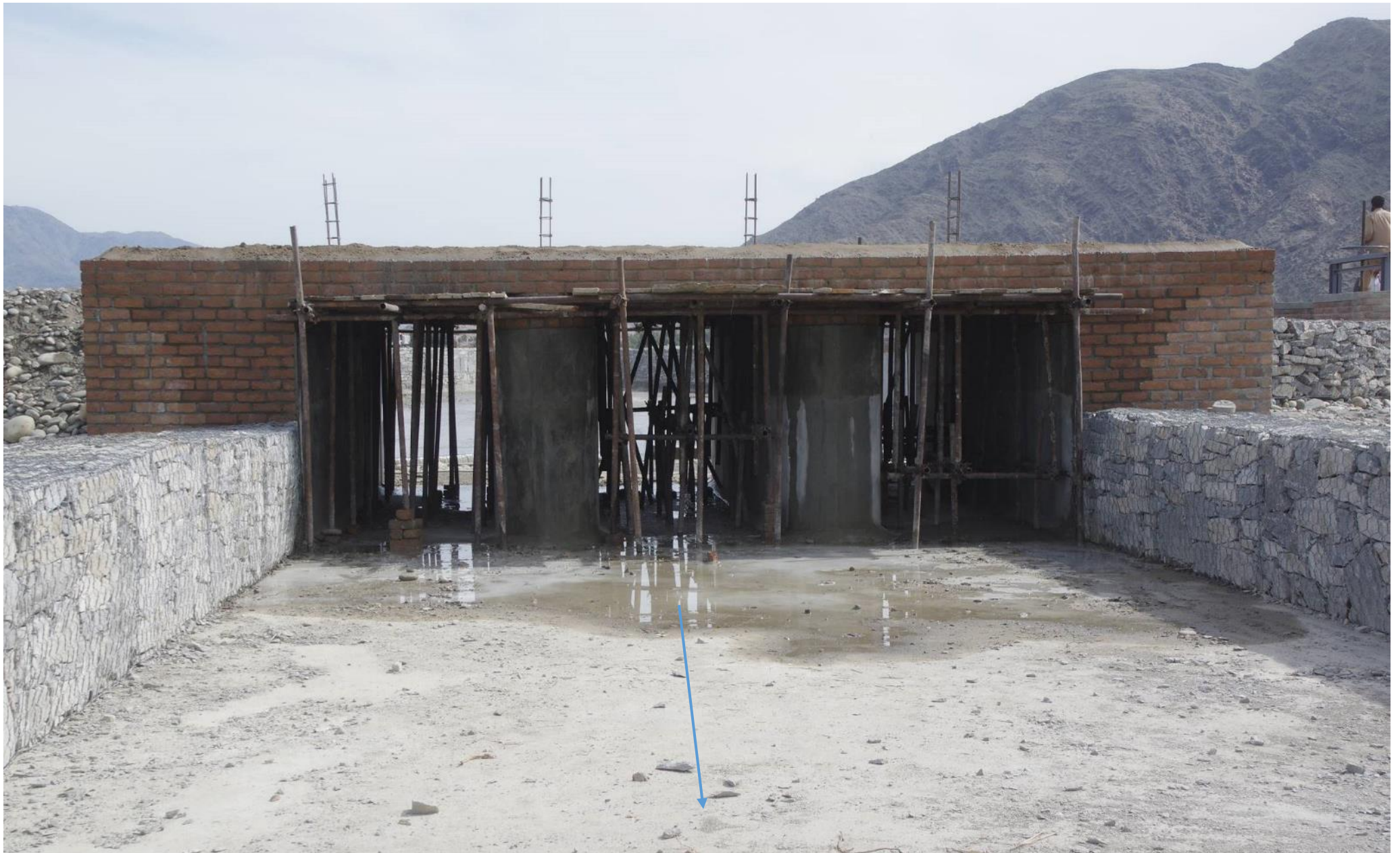
主送水門の下流側。2017年3月30日
