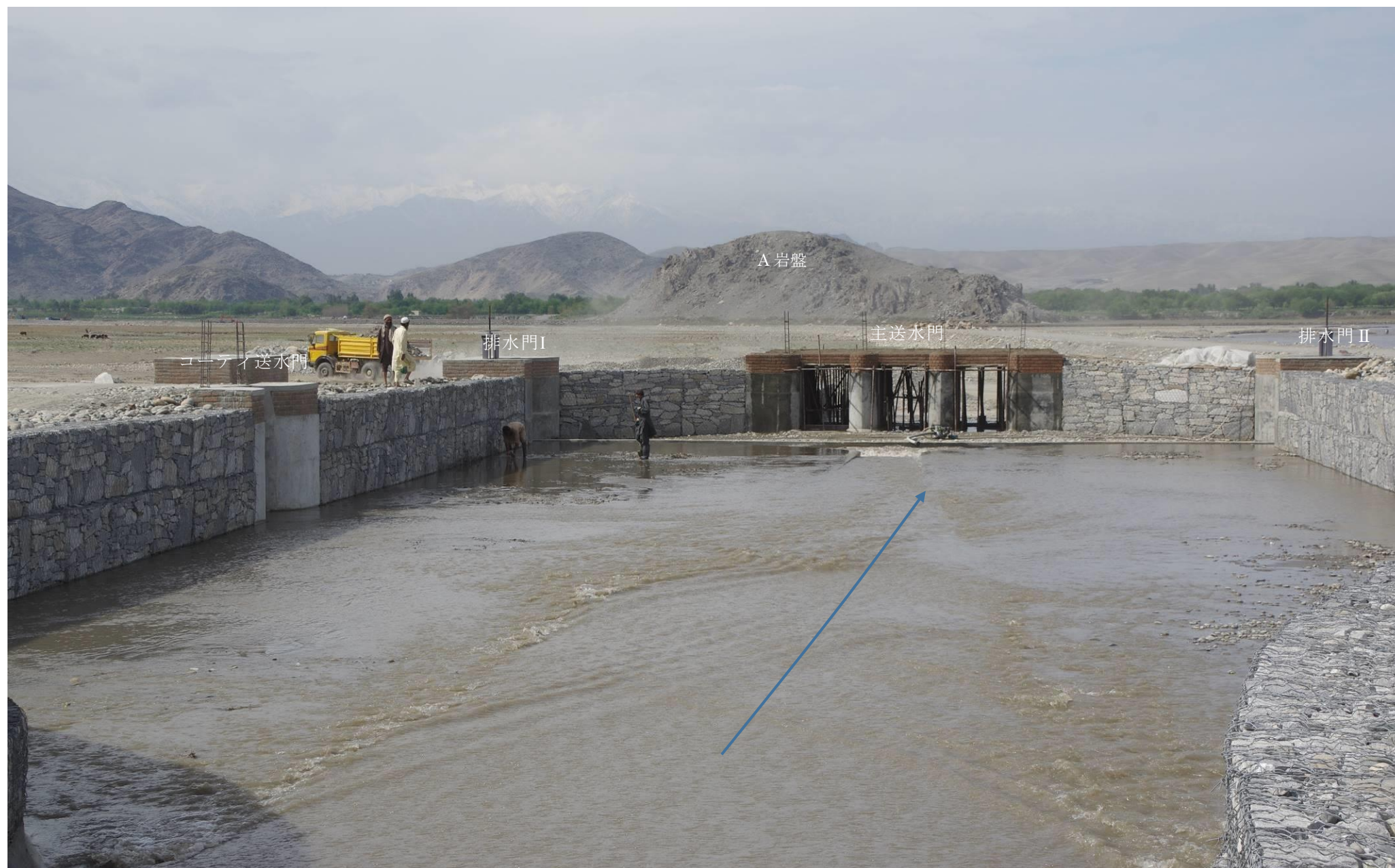
内部と各水門を完成した沈砂池。2017年3月30日
