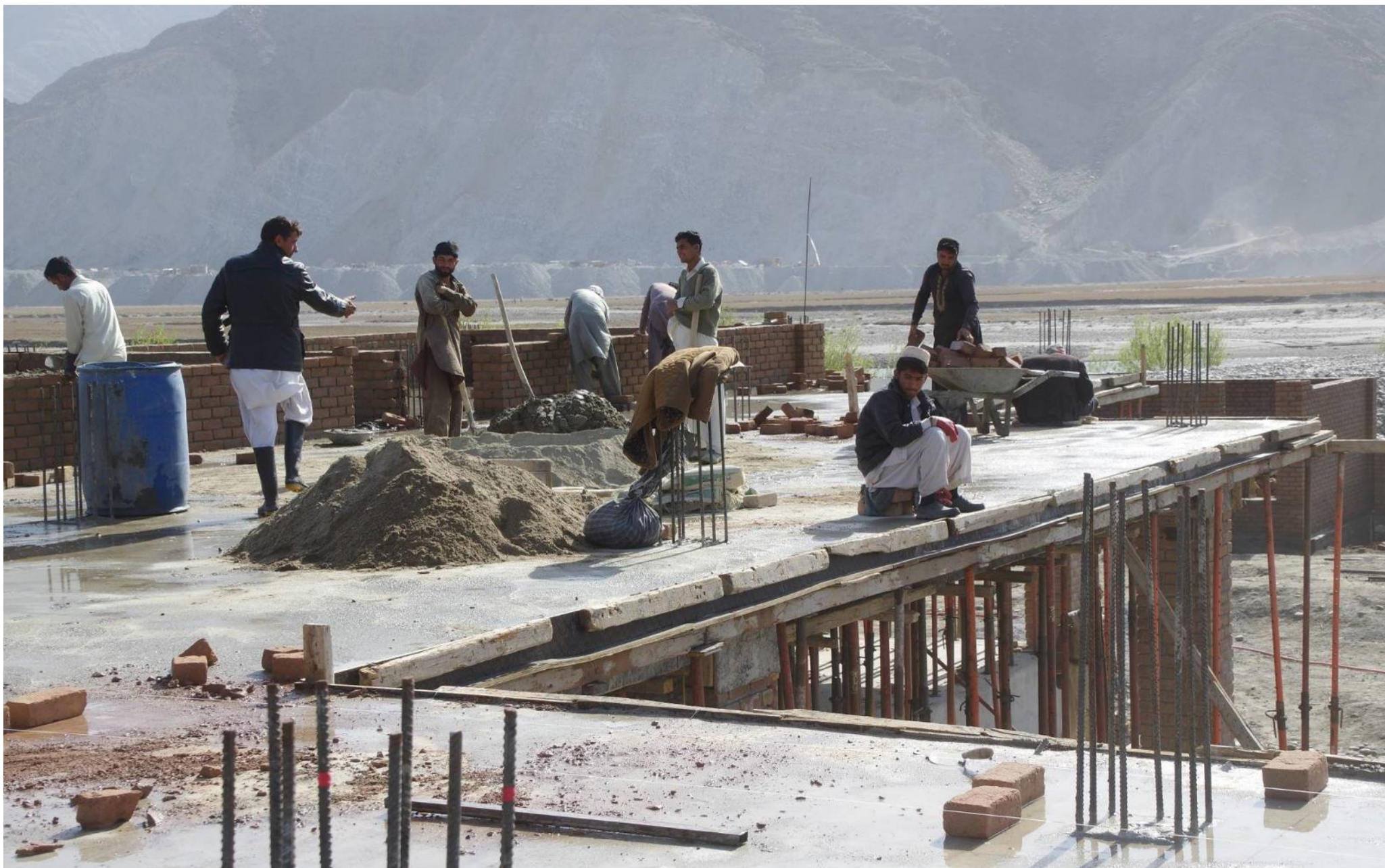
訓練所は2階部分の建設に入っている。2017年3月11日
