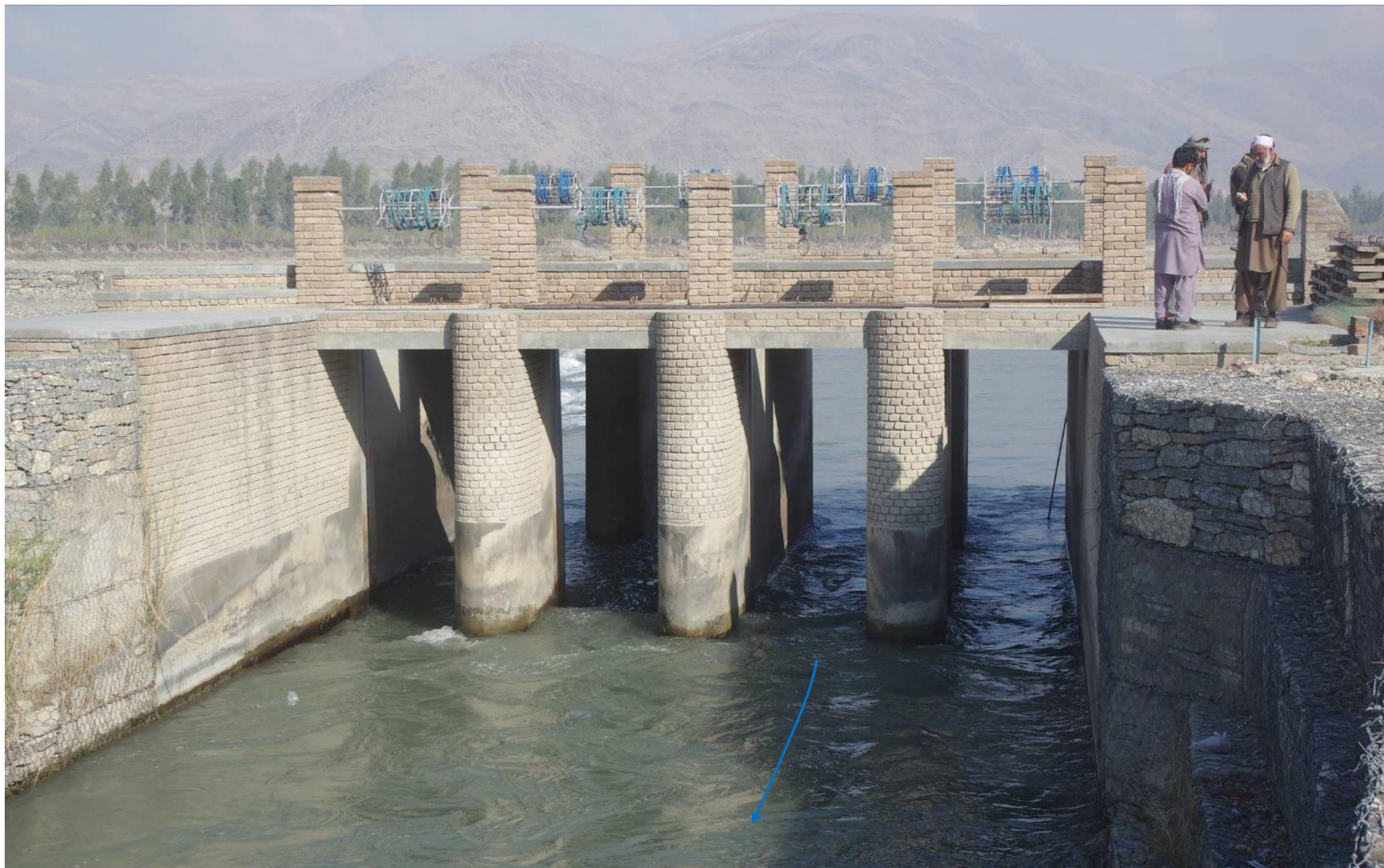
カマ第二堰取水門。2017年3月9日
