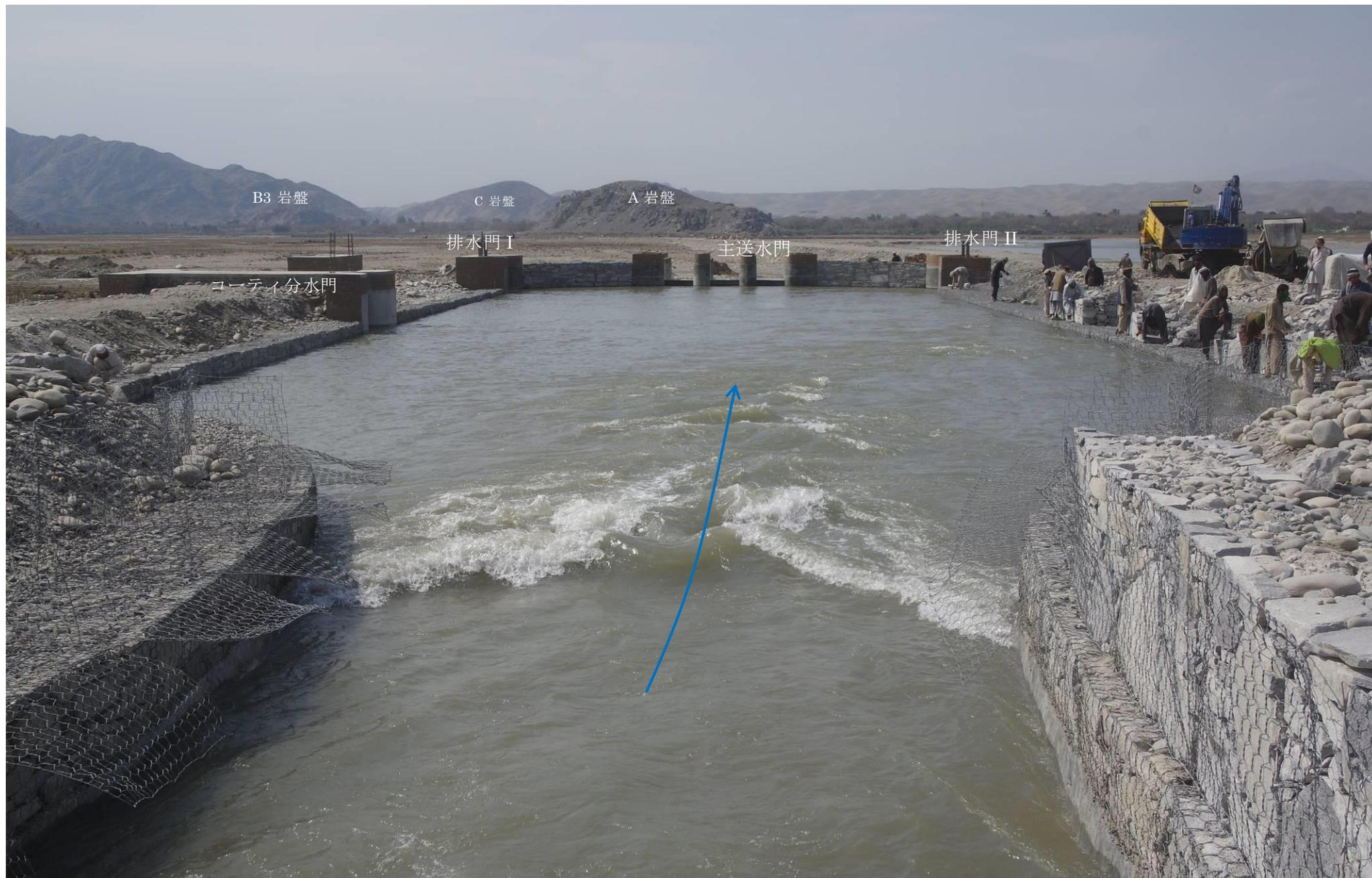
沈砂池左岸の様子。流入量は毎秒約 5 m<sup>3</sup>、水深は送水門床面から 80 cm 以上、排水門床面から 155 cm で安定、十分な送排水が可能。2017 年 3 月 7 日
