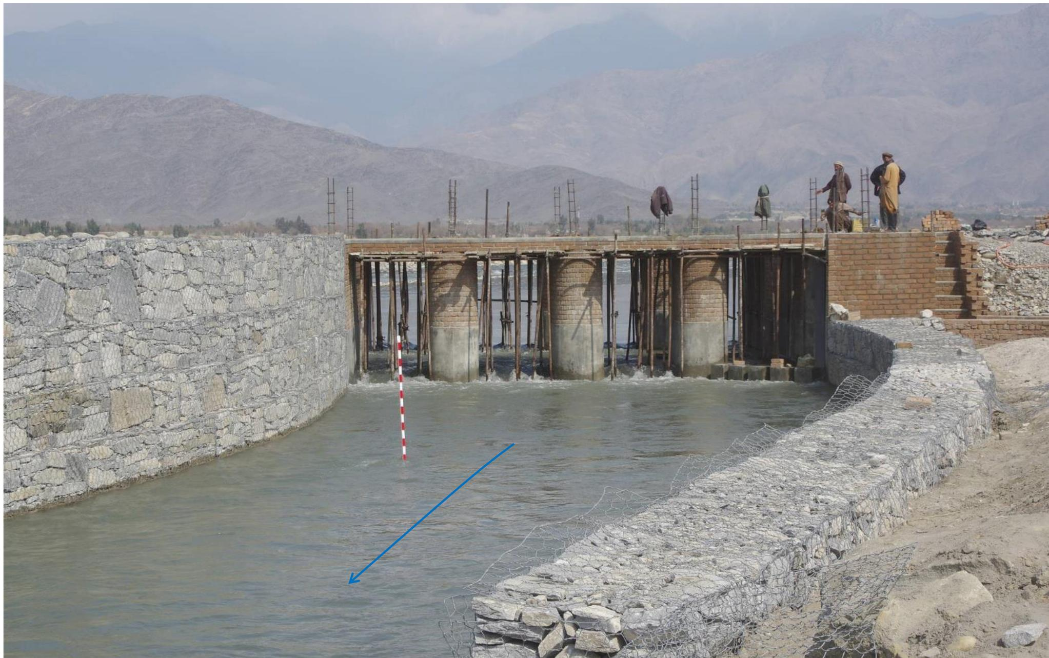
全開時（流入量；毎秒約 5 m<sup>3</sup>）の沈砂池の様子。排水門 II だけを全開している。送水門床面の水深は 80～85 cm で安定、2017 年 3 月 7 日
