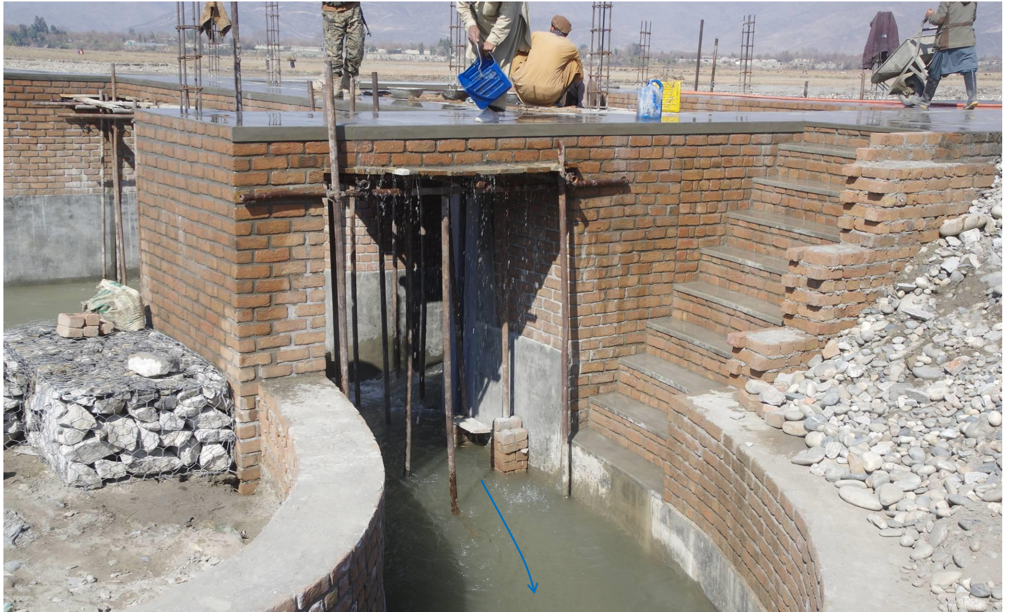
カチャラ分水門。最大 2.0 m 3 /秒まで供給できる。実際にはそんなに要らない。2017 年 2 月 26 日
