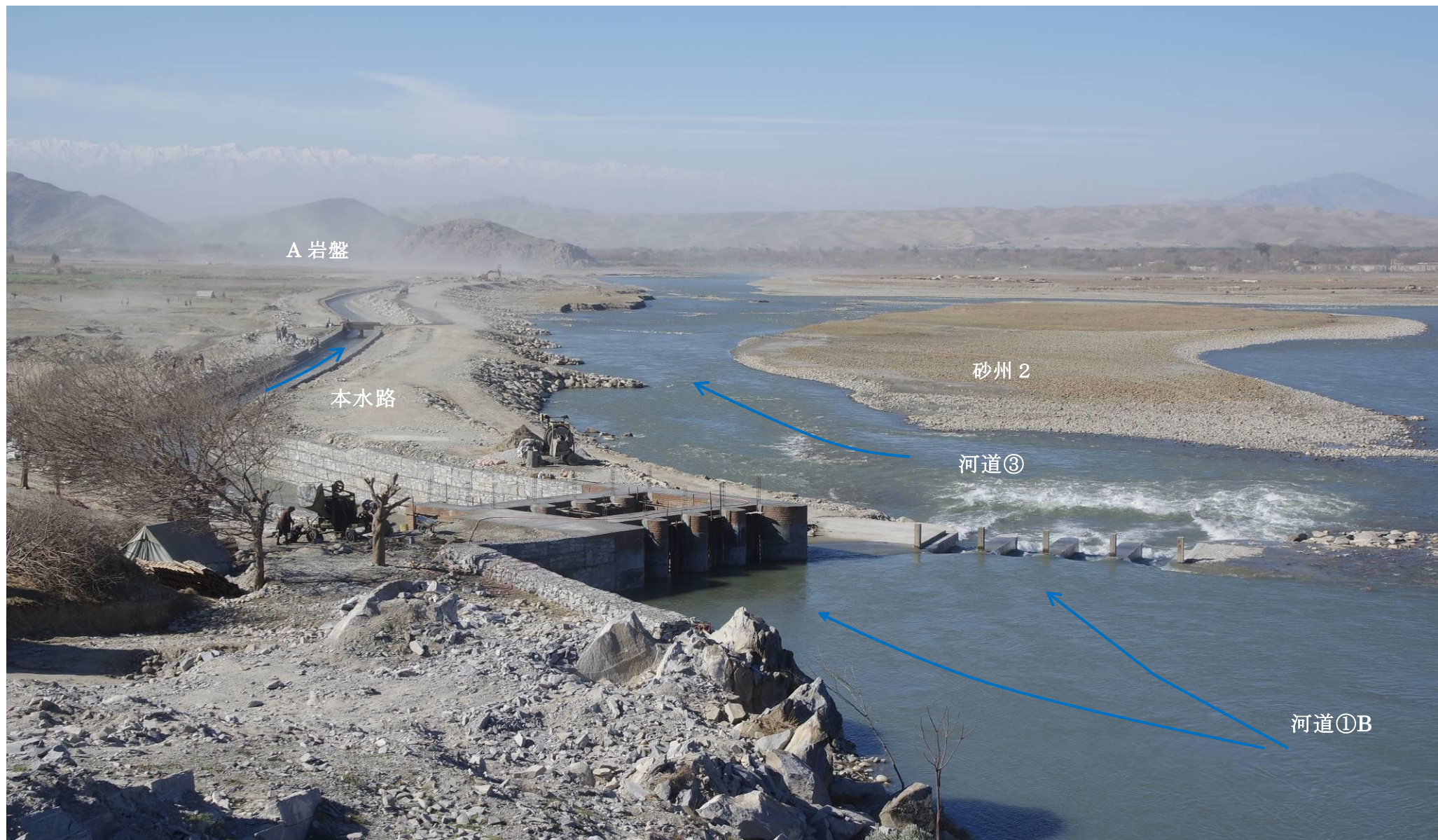
仮工事を終えたMII（マルワリードII）堰と取水門。2017年2月25日
