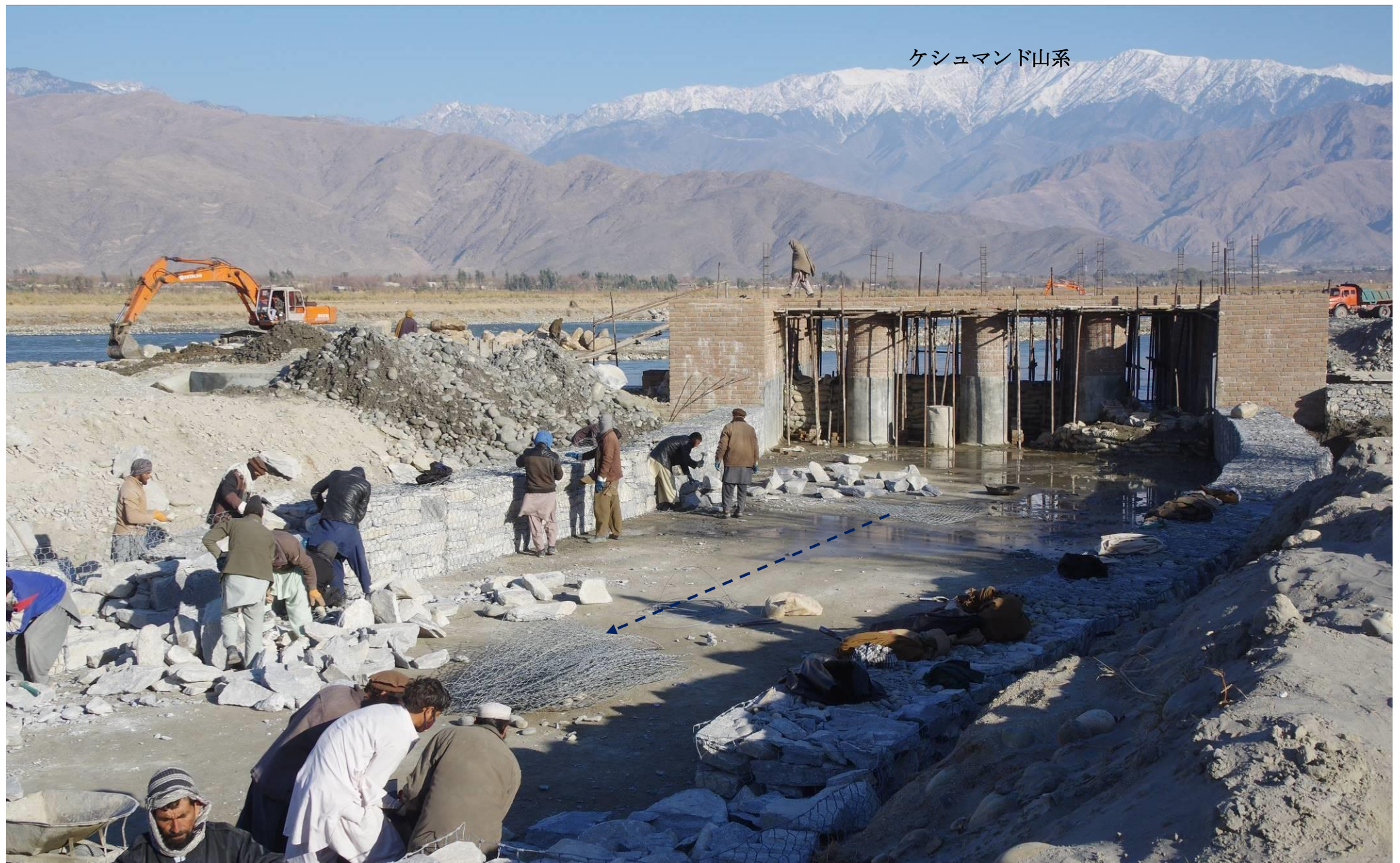
同部を下流側から見る。2017年1月12日
