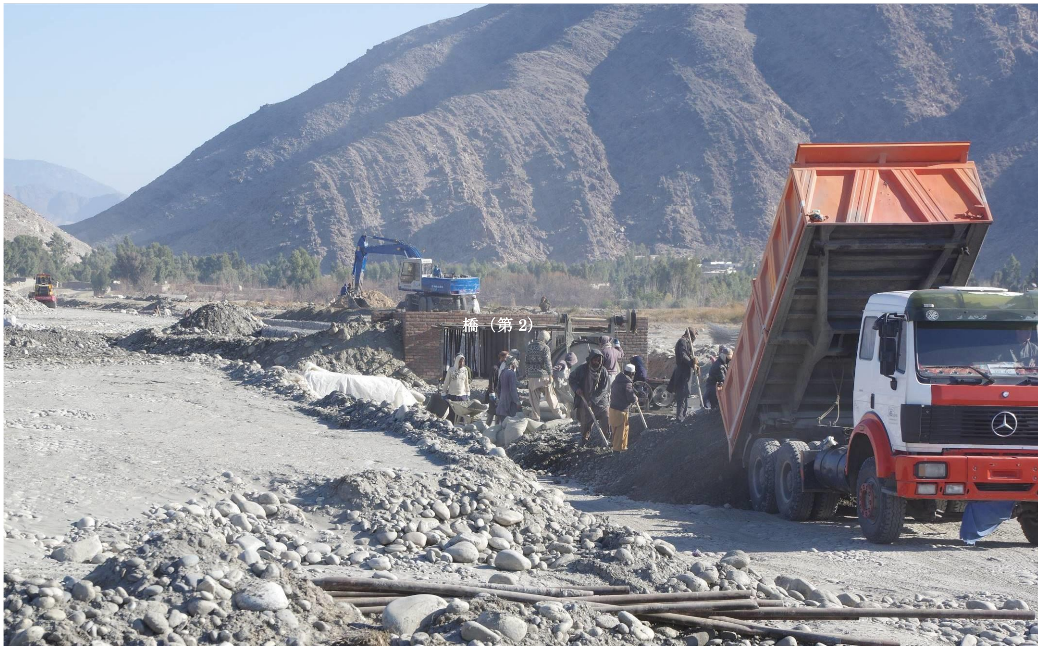
橋を下流側から見る。2017年1月12日
