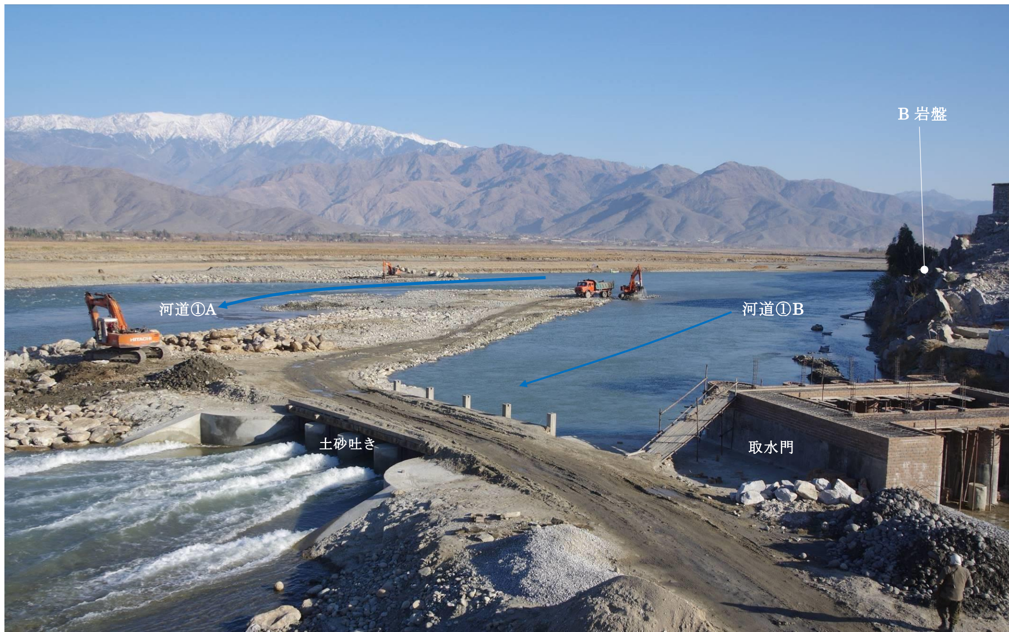
取水口付近全景。2017 年 1 月 12 日
