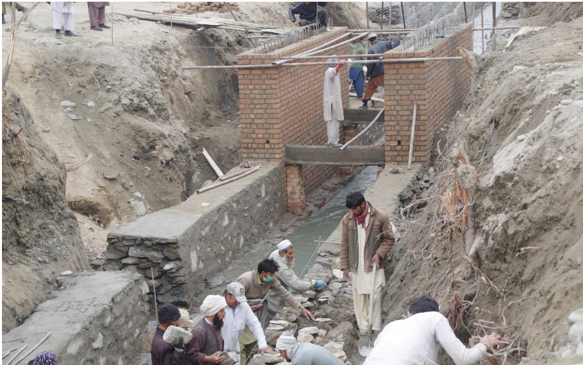
架橋中のX0橋。1400m地点。(動画あり) (A区 700m地点) 2017年1月2日
