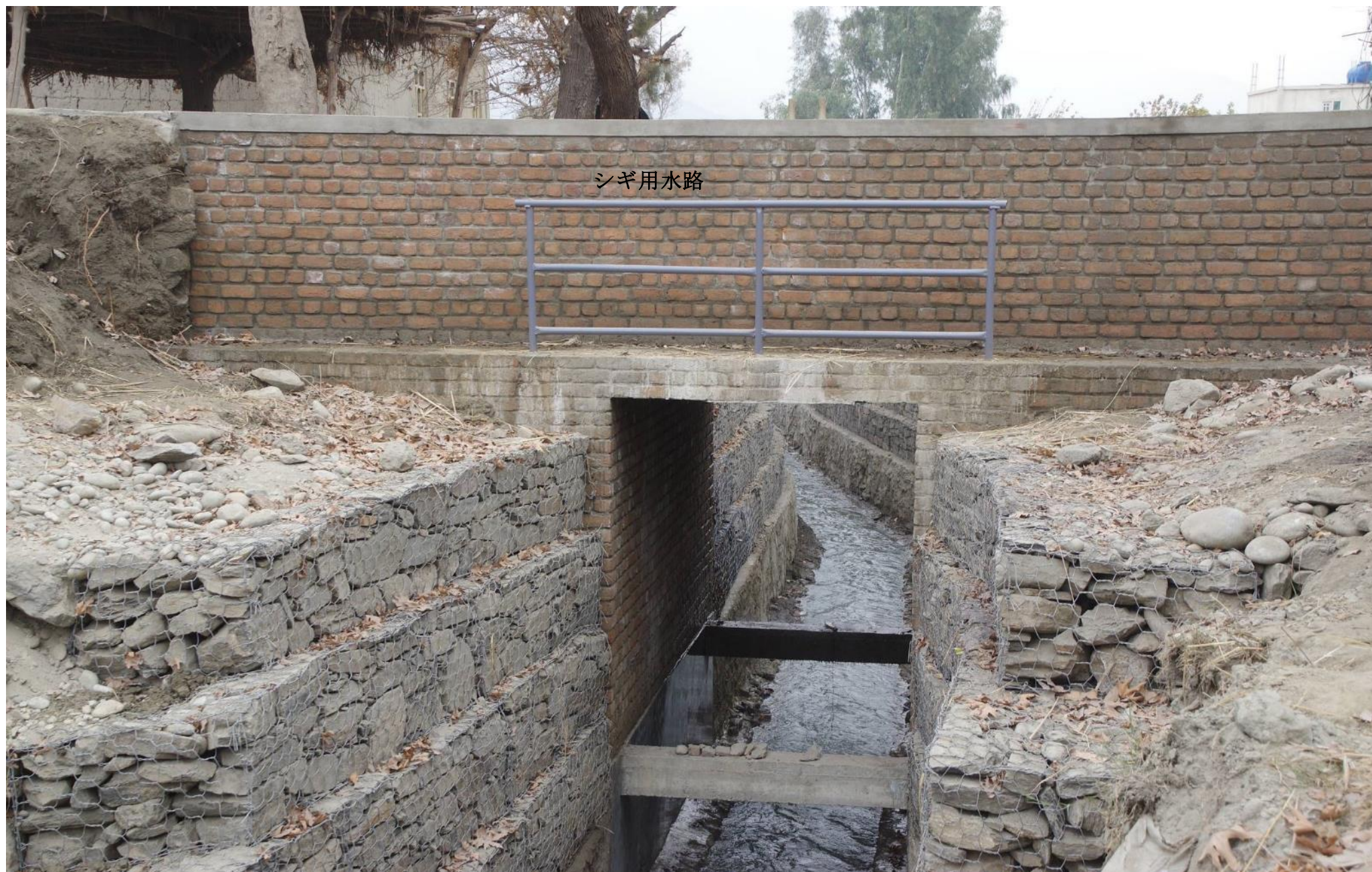
完成した 1230m地点（A区 530m地点）のシギ水道橋。2017 年 1 月 2 日
