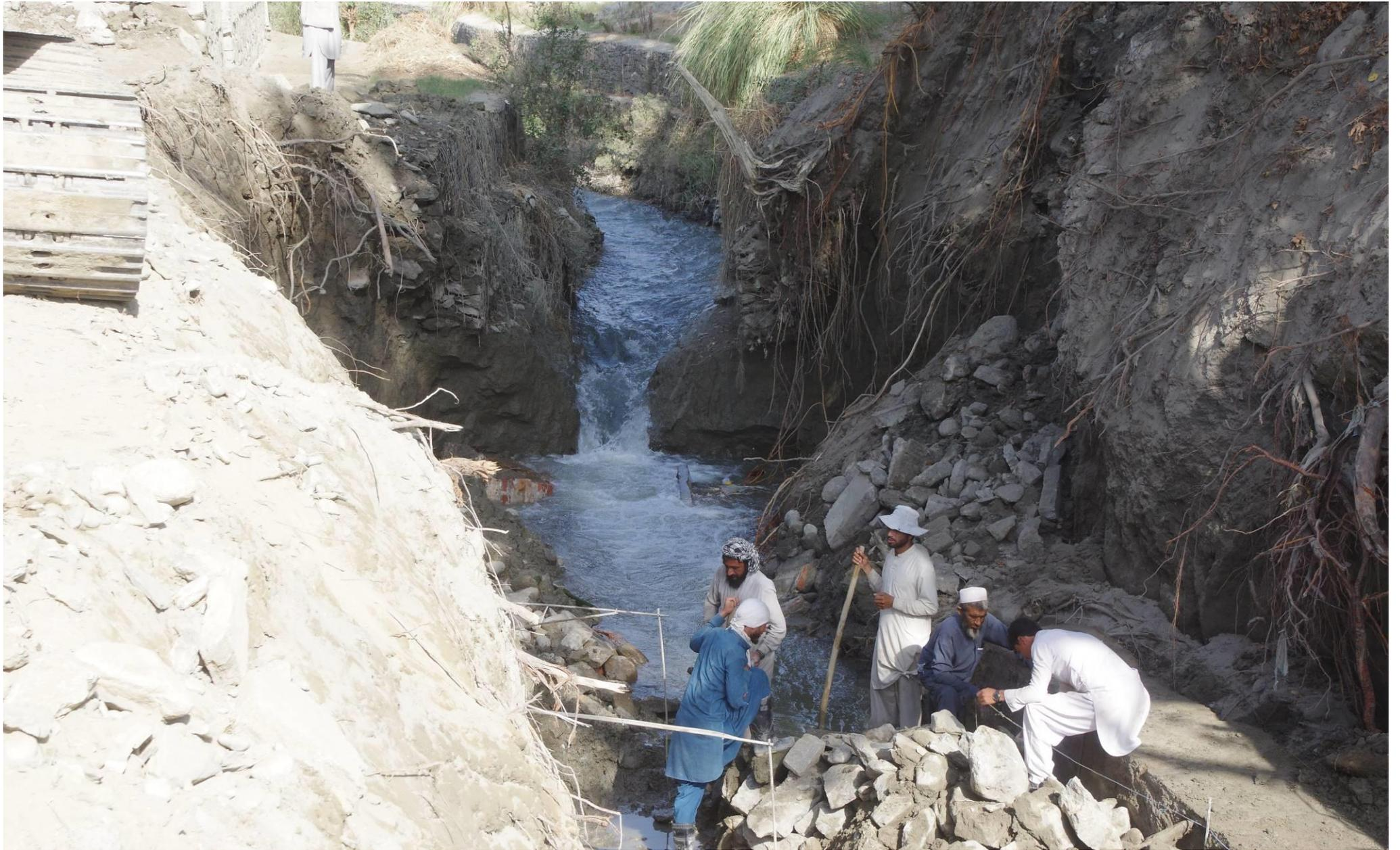
これより上流は、分厚い粘土層だが、「硬い粘土」で、まるでプラスチックのゴムのようなものである。数年前置いた籠がまだ残っている。シャベルでは掘り崩せない。
