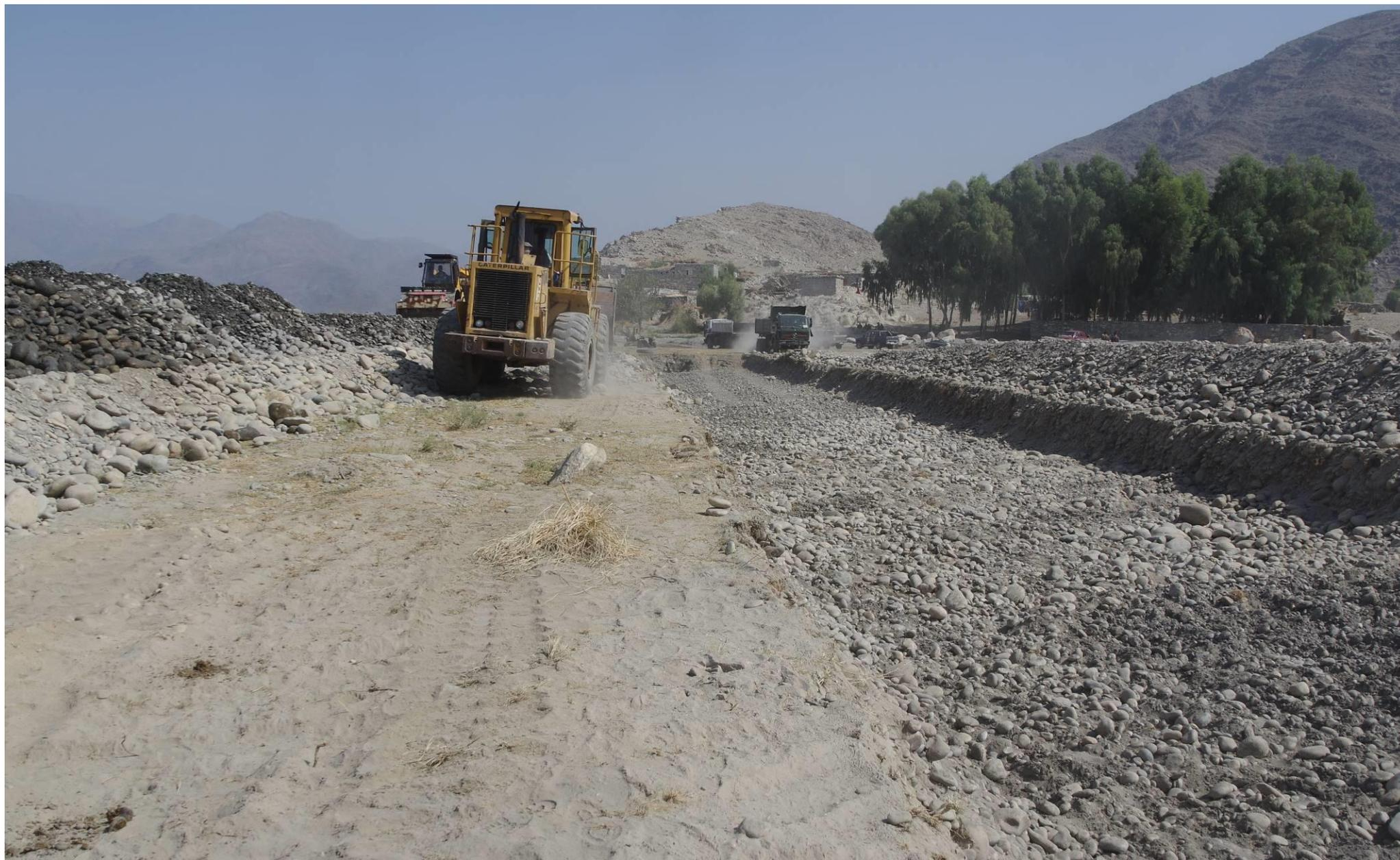
1200m 地点に達した排水路。シギ用水路の水道橋を撤去。新設を開始。2016 年 10 月 14 日
