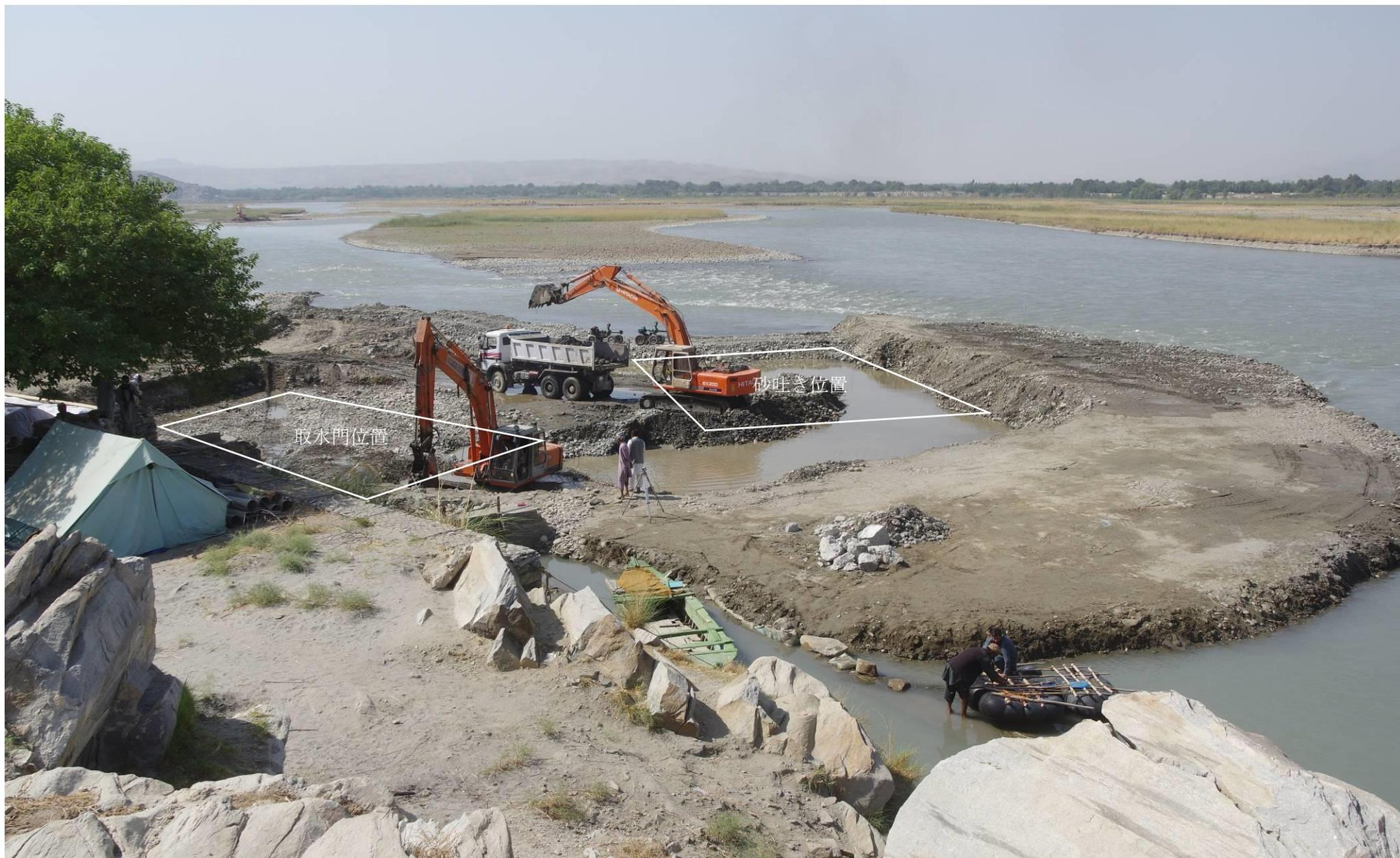
基礎工事でむき出された岩盤。平たく整形して基礎を置く。2016年10月14日
