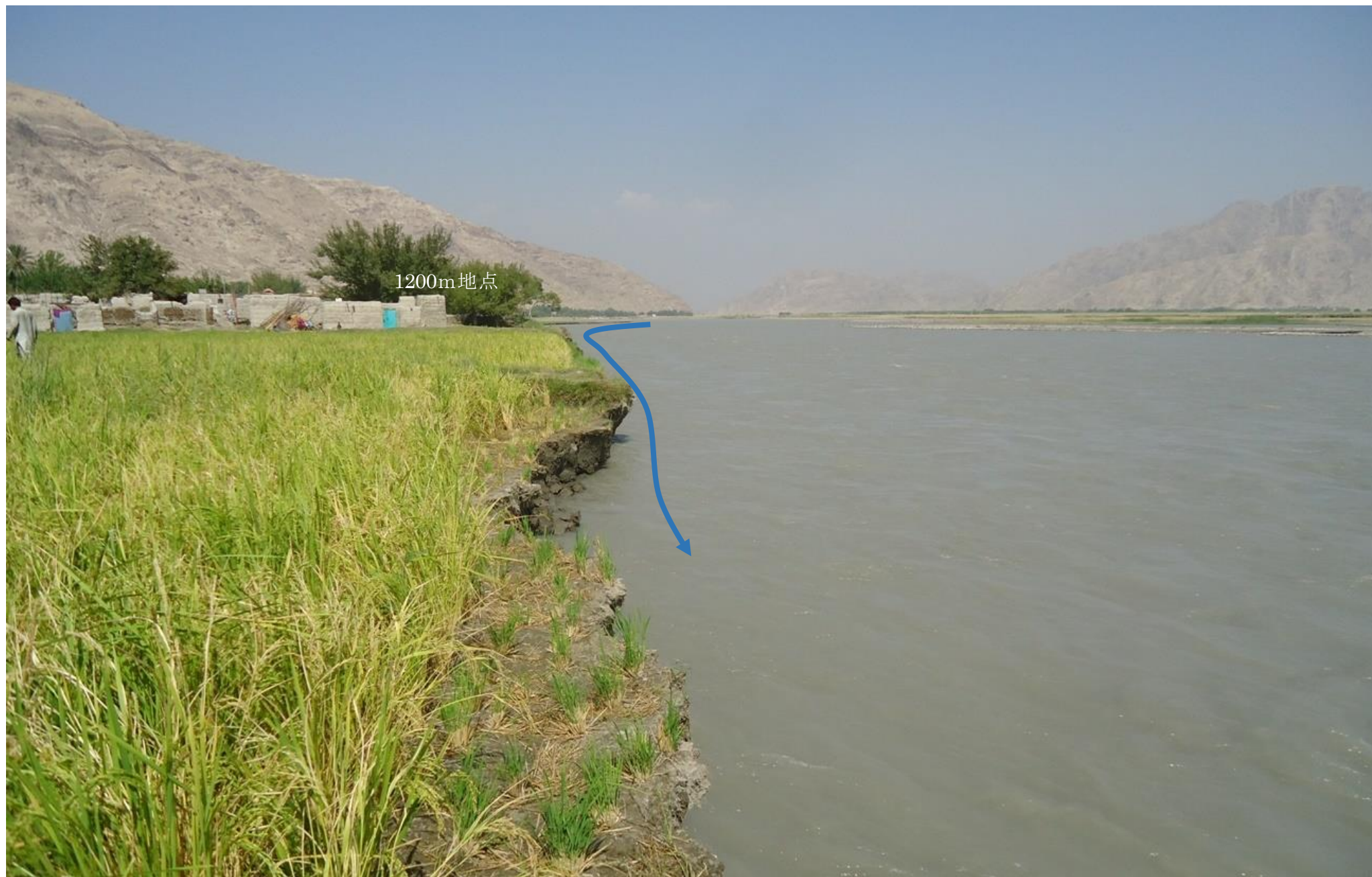
田畑と家屋流失直後の 1200m地点。着工直前の状態。侵食線がそのまま護岸線となっている。2014 年 9 月 22 日
