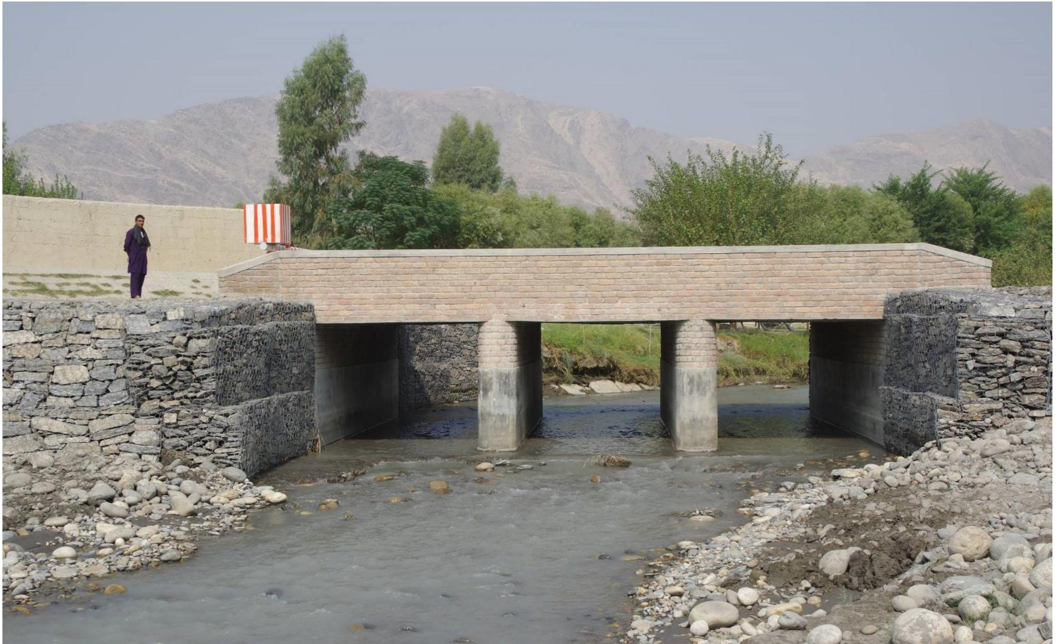
侵食防止に施された護岸。ミラーン側の護岸は計 2,800m、12~50m間隔に石出し水制を置く、記録的なものとなった。ミラーン堰の建設意義の一つが、クナール河における護岸法の会得だった。やぼったいが機能は十分。2016年9月26日
