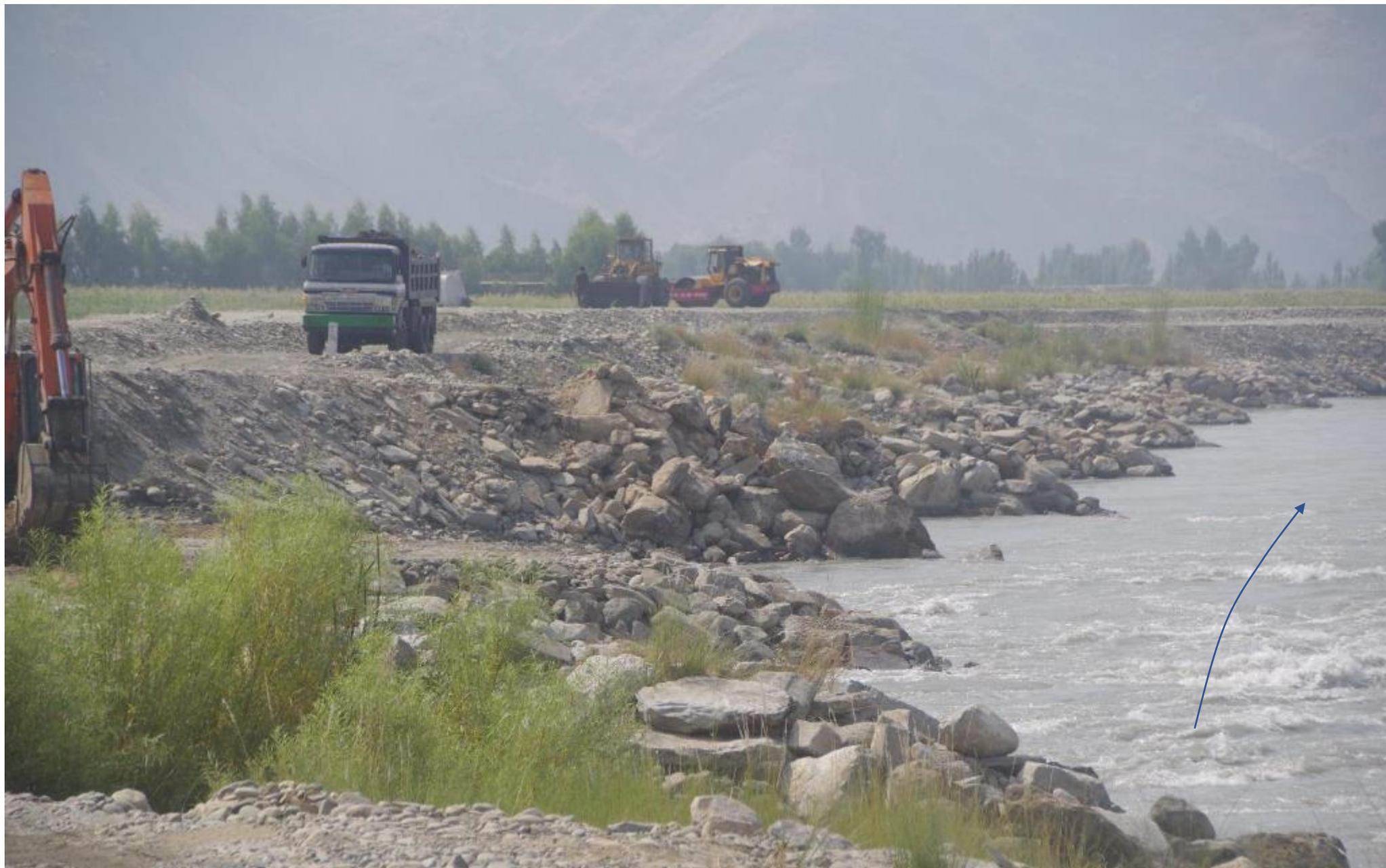
護岸最終、8.5 km地点。河道整備予定の場所は、多列砂州と複数の河道が入り乱れ、河道変化の激しい場所だ。基本的には幅の広い斜め堰の建設が方針だが、まだ十分な測量と観察が必要だ。予定では幅約 250mの石堰建設となる。2019年9月25日
