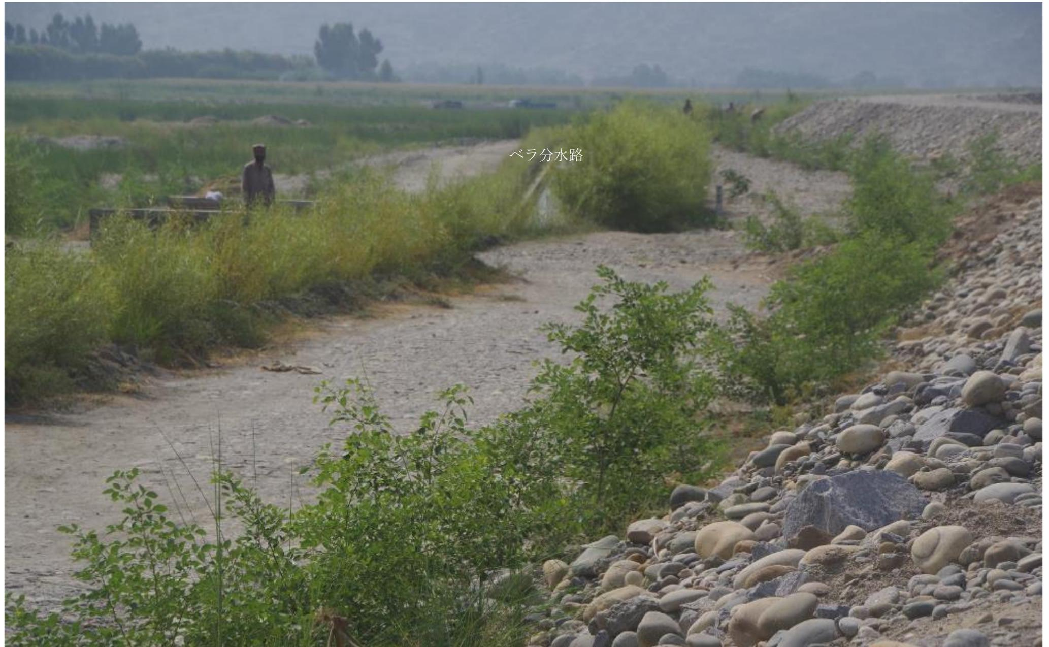
浸食防止は石出し水制を 25～50m 間隔で設置し、先端に発生する深掘れを根気よく補修していくものだ。ここでも膨大な巨礫を要し、石材輸送が大きな仕事になっている。2019 年 9 月 25 日
