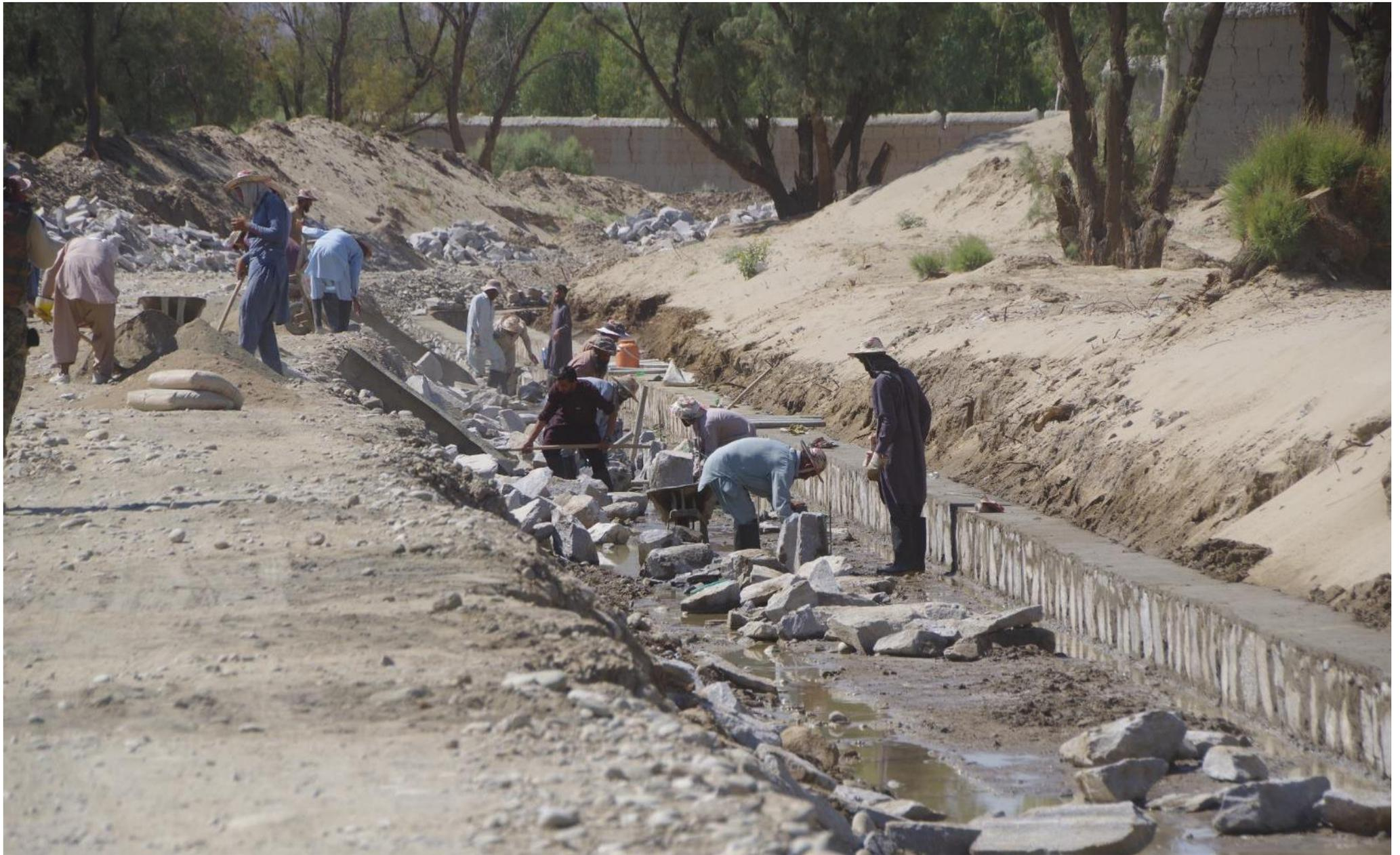
練石積みで密閉せず、浸透水を流路に導くよう、50 cm間隔で径2インチ（約5 cm）の穴があけてある。2019年6月16日
