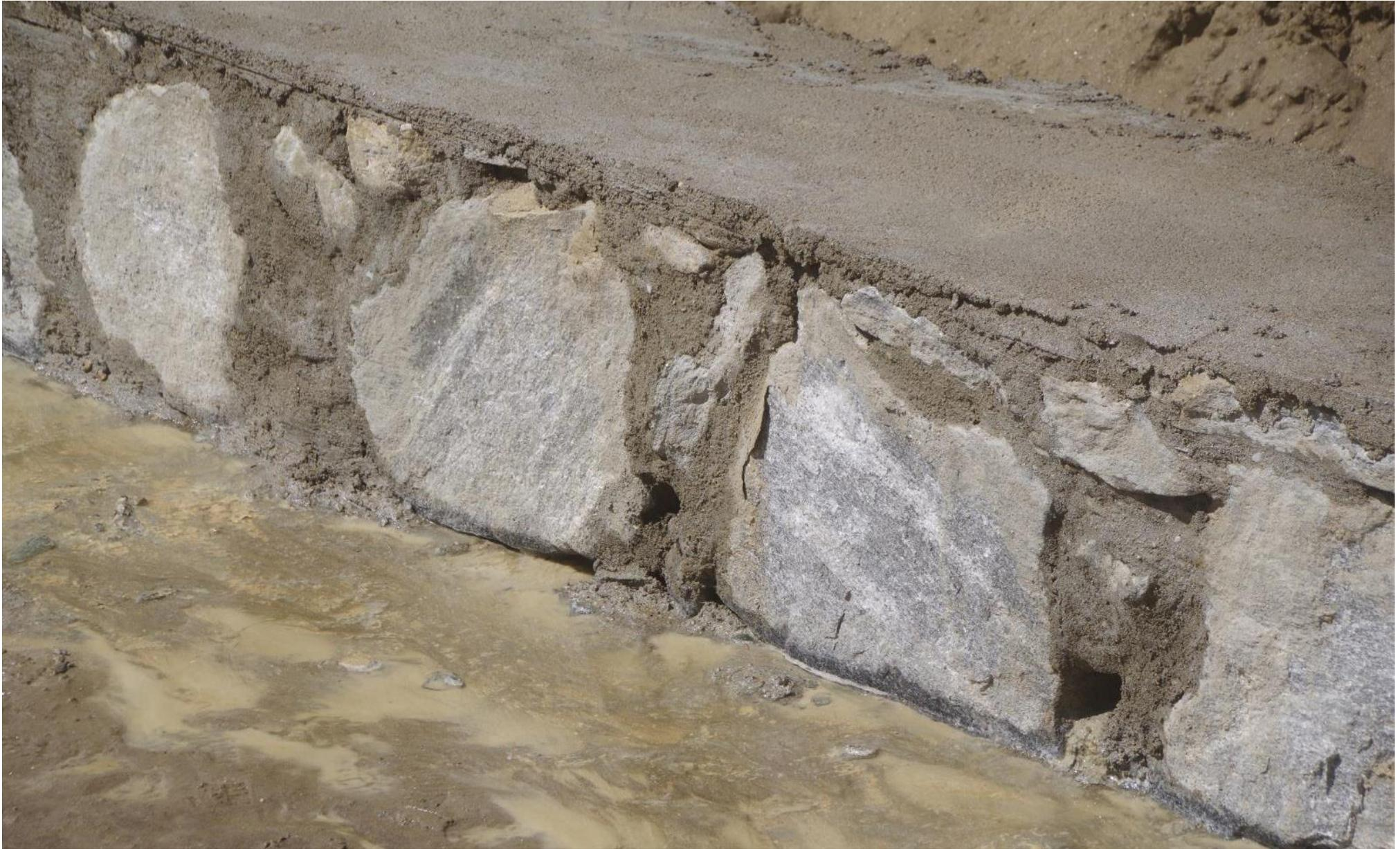
約 600m地点。貯留水の水位が最も高く、著しい軟弱地盤であったところ。ソイルセメントによる固化、砂利層による置換が成功してライニングが可能となり、工期を大幅に短縮した。2019年6月16日
