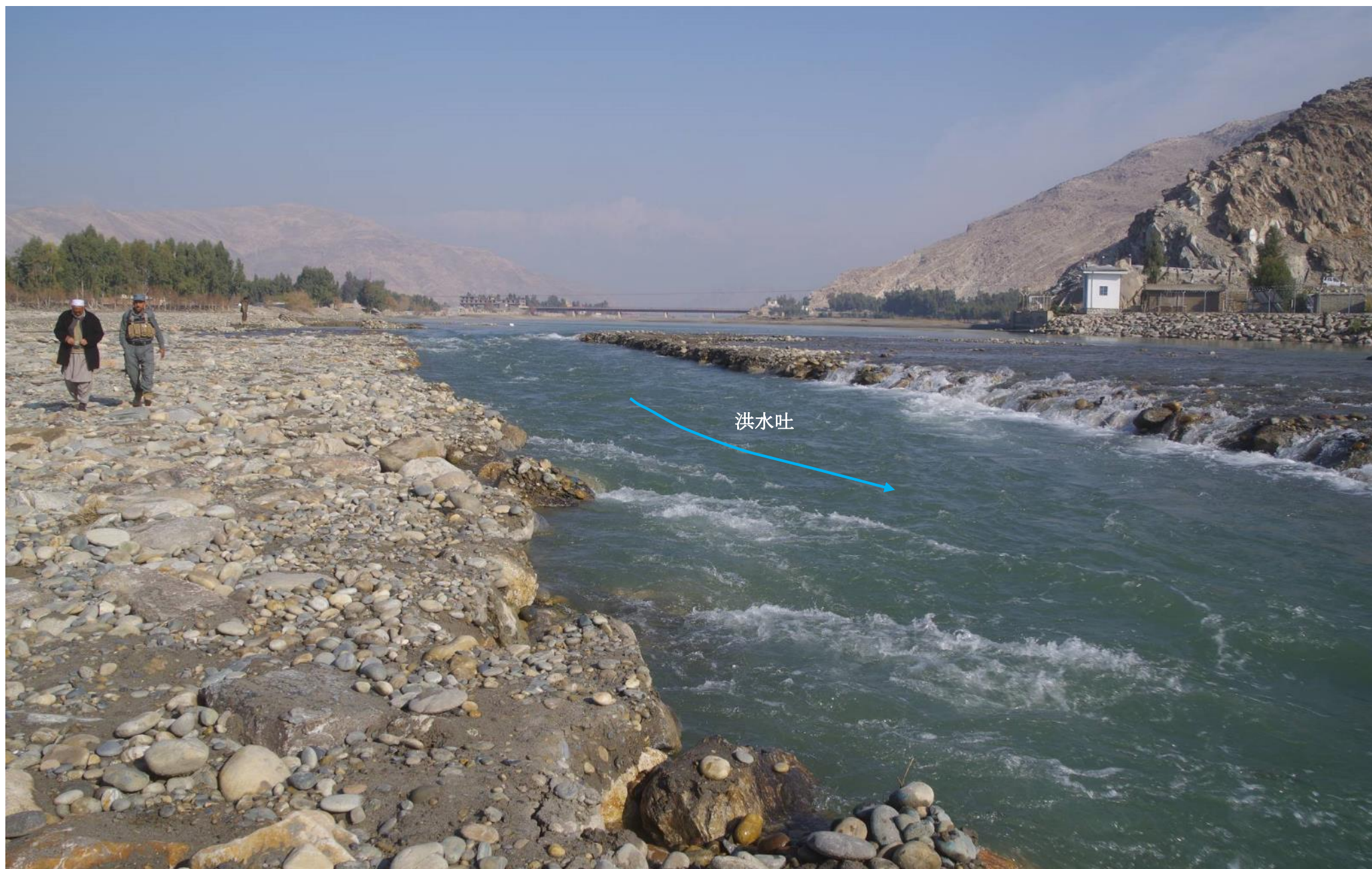
洪水吐を近くから見る。2019 年 1 月 21 日（動画あり）
