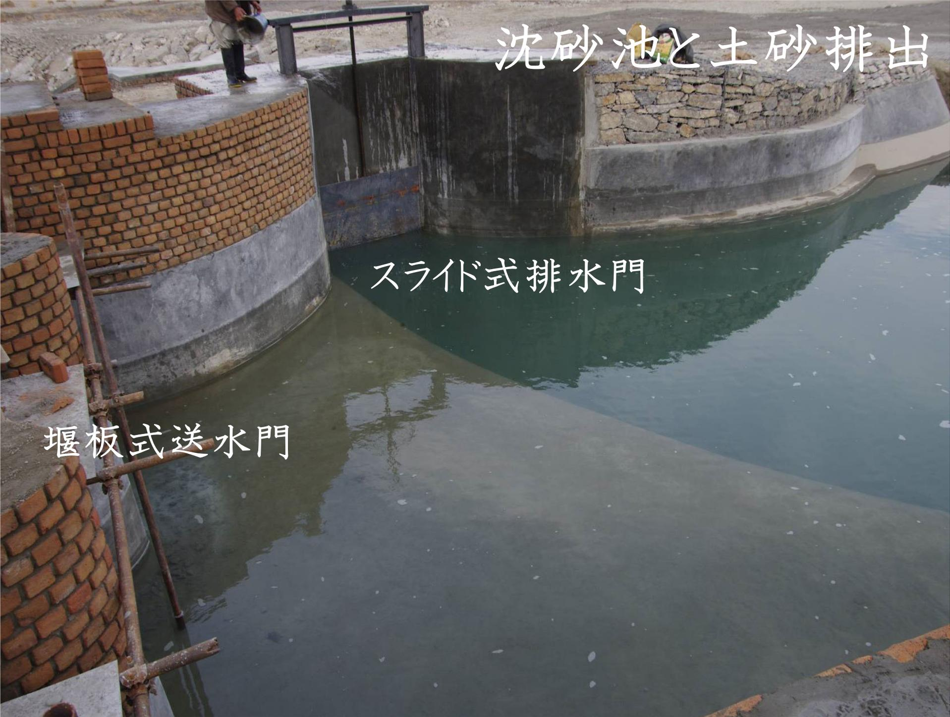
沈砂池と土砂排出
