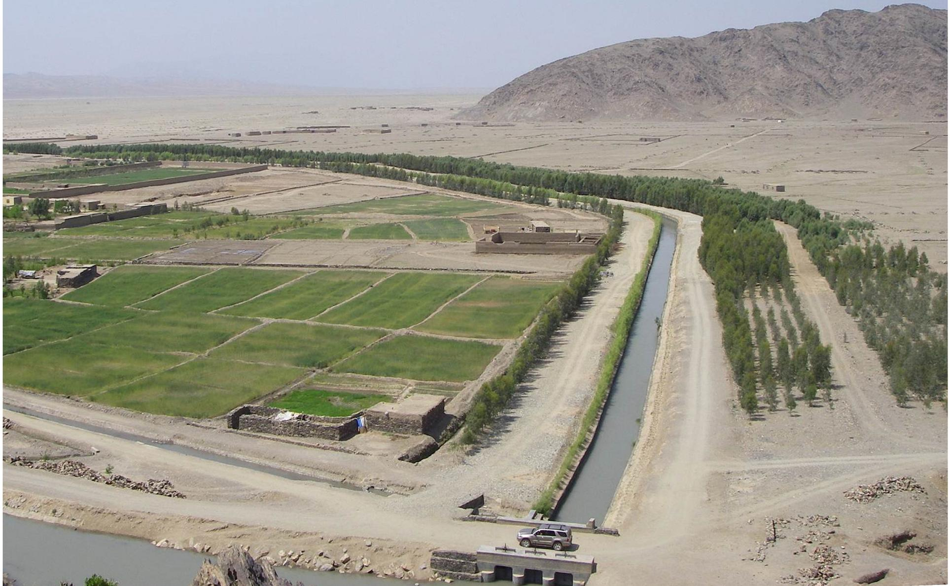
ガンベリ沙漠とシギ村（主要排水路、防砂林、洪水路、開墾地、湿地帯ら）の概要 → 洪水進入路
