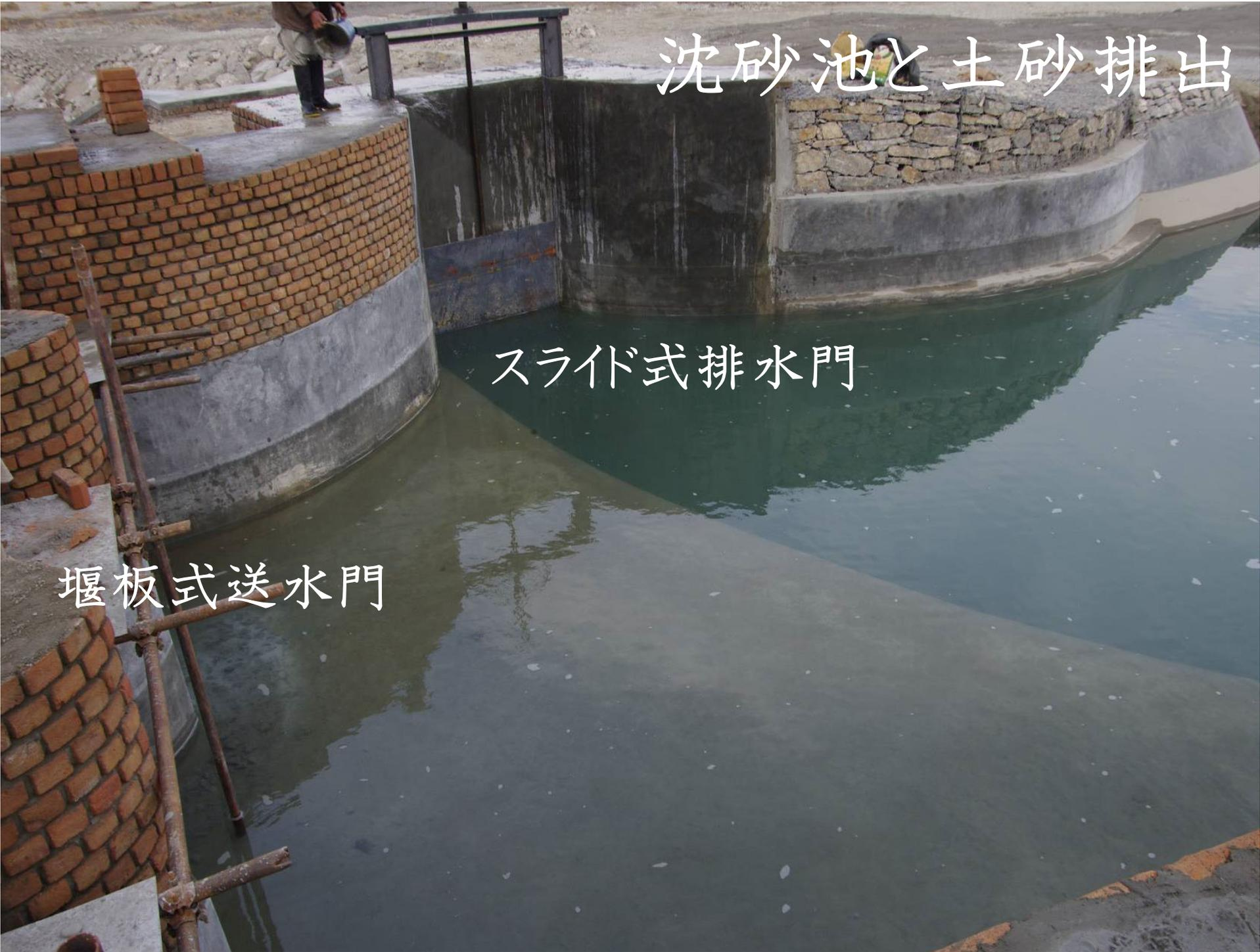
沈砂池と土砂排出
