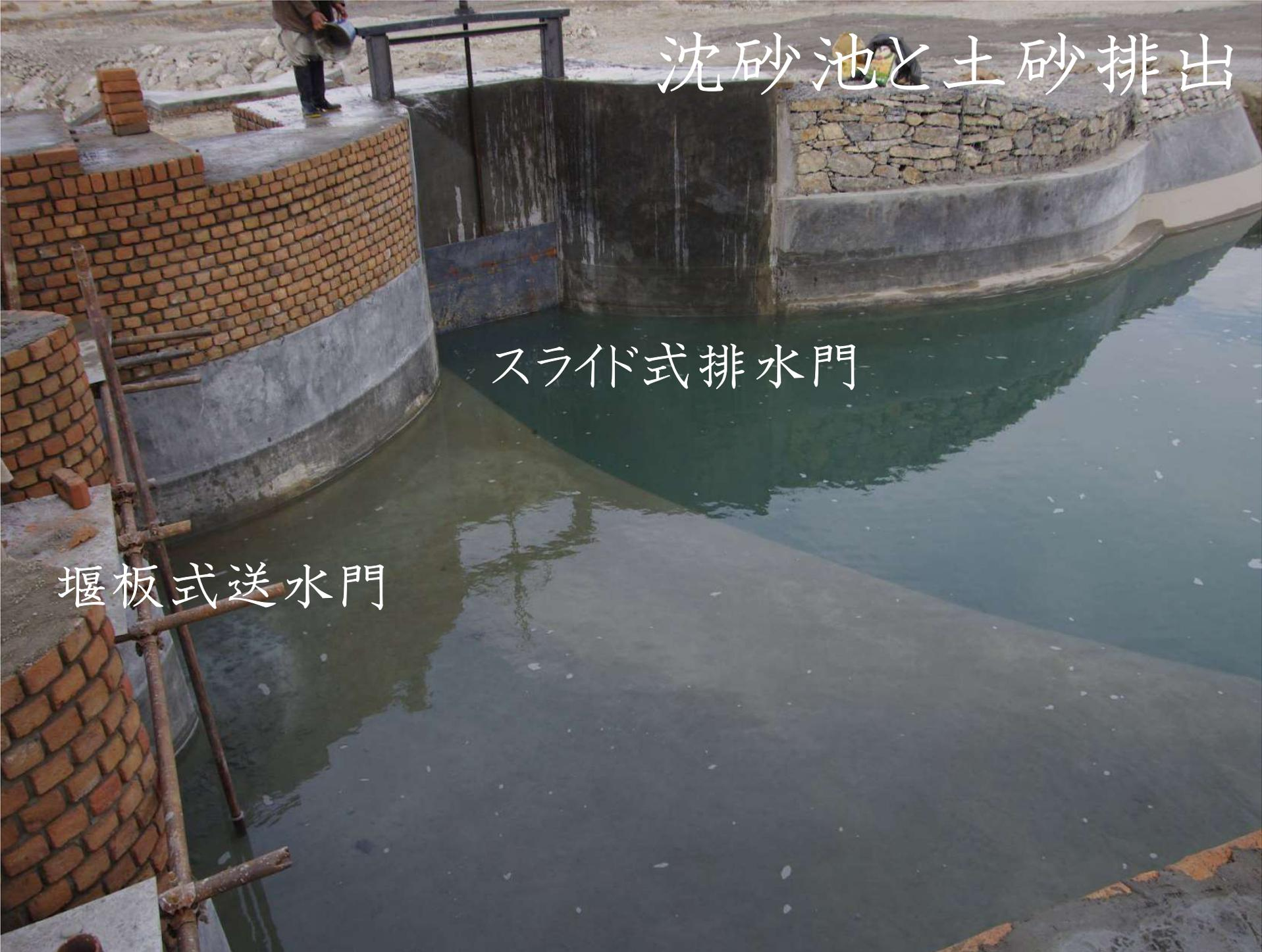
沈砂池と土砂排出
