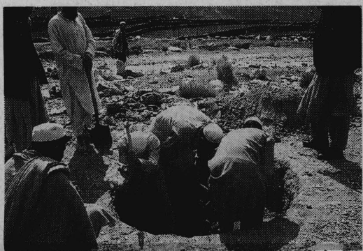
巨石に直面しながらの井戸掘り作業
